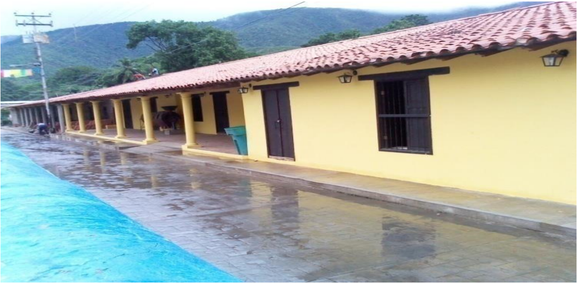
Edificio sede de las oficinas administrativas y almacenes de cacao, Empresa Campesina Chuao. Fotografía tomada por el autor, año 2018.
