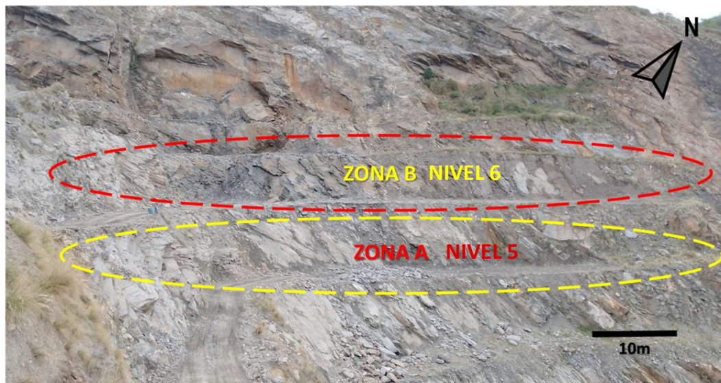
Figura 30. División por zona del frente del afloramiento principal de la Mina 2.
