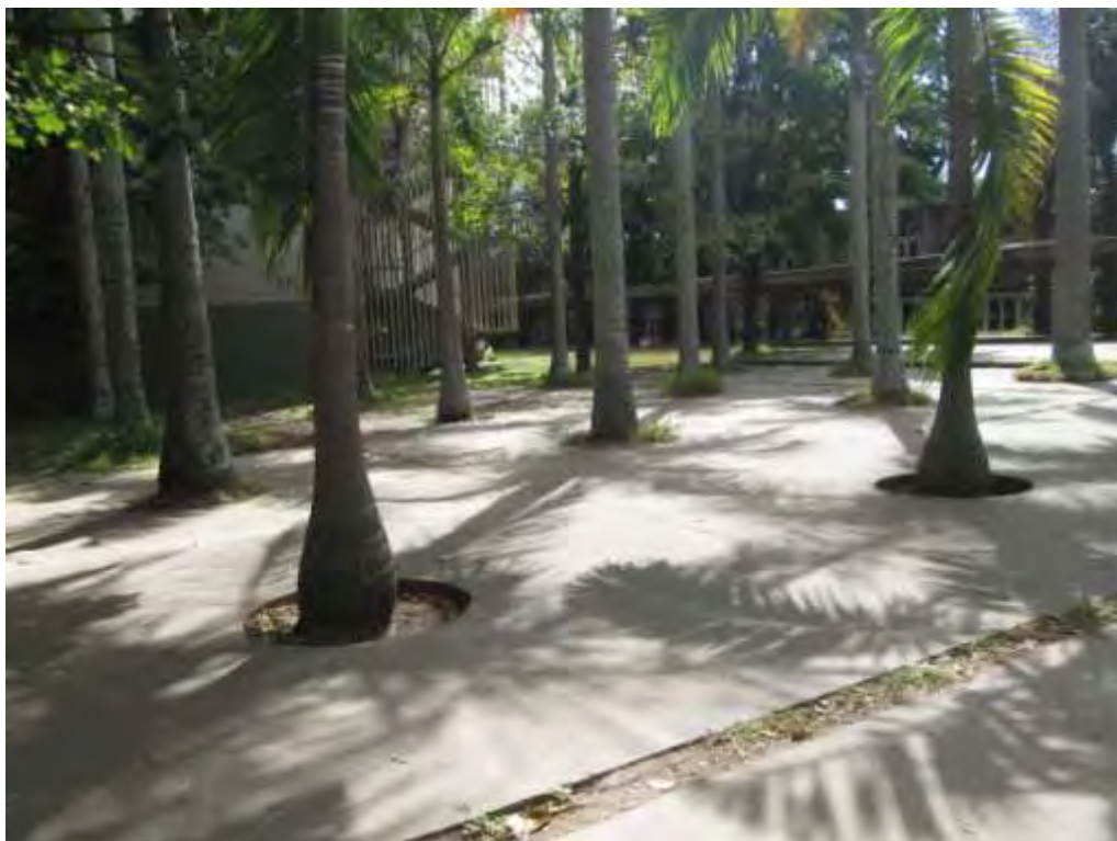
Imagen 39. Vista lateral de los “pilotis” del damero de chaguaramos , sector B.
