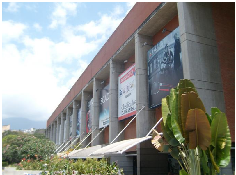
Foto 15, acabados en fachada Oeste
