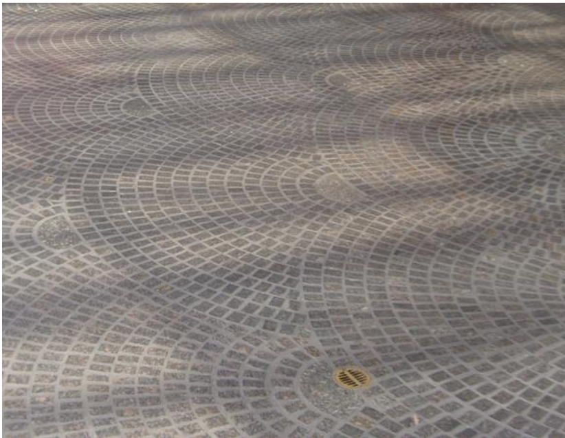
Foto 18, pavimento de baldosas de granito
