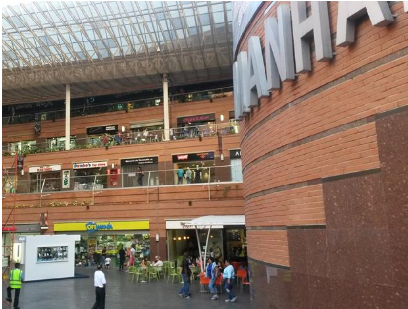
Foto 8, revestimiento en fachada
