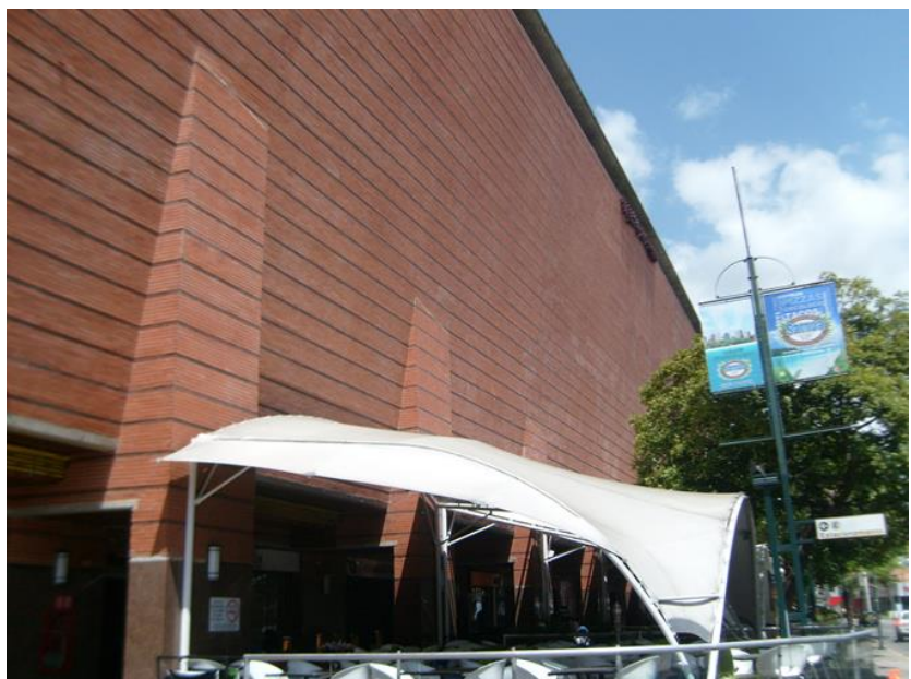
Foto 19, revestimiento de fachadas
