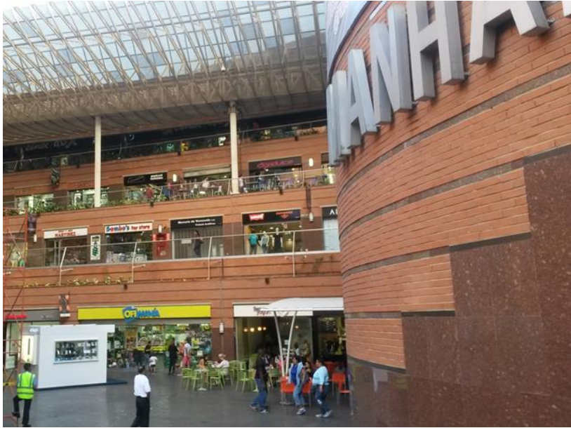
Foto 20, revestimiento de fachadas
