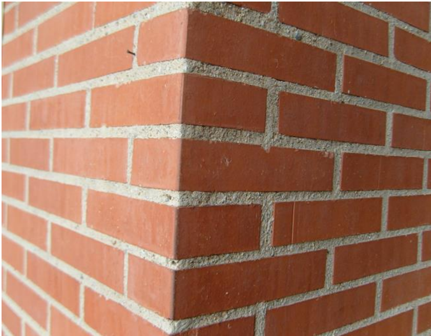
Foto 13, revestimiento panelas de arcilla
