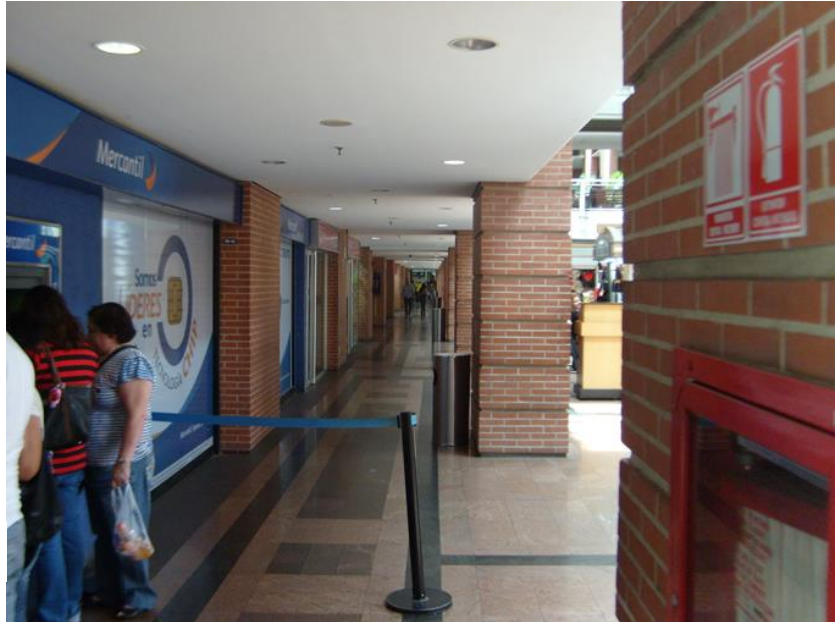
Foto 14, revestimiento de panelas de arcilla en columnas
