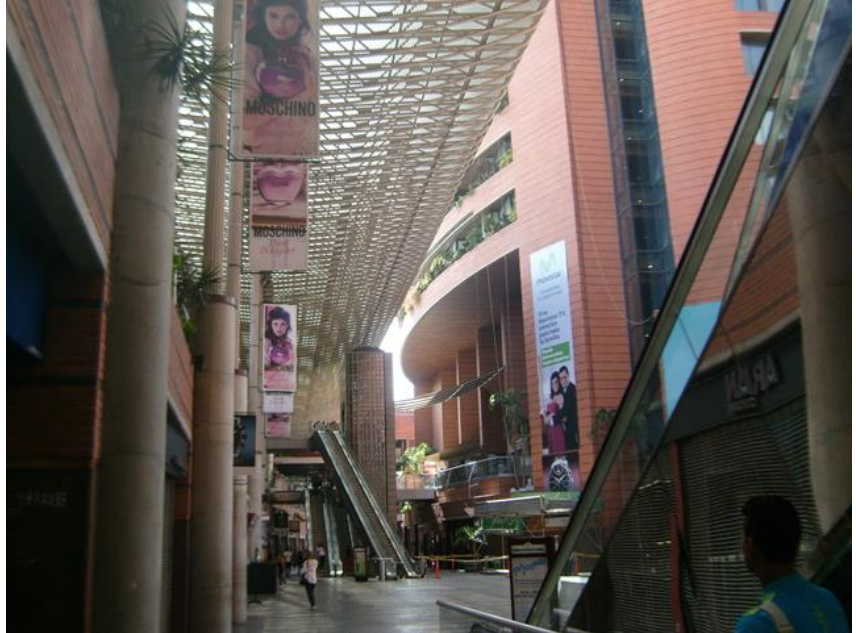
Fotos 6, Vista interior y 7, fachada Norte
