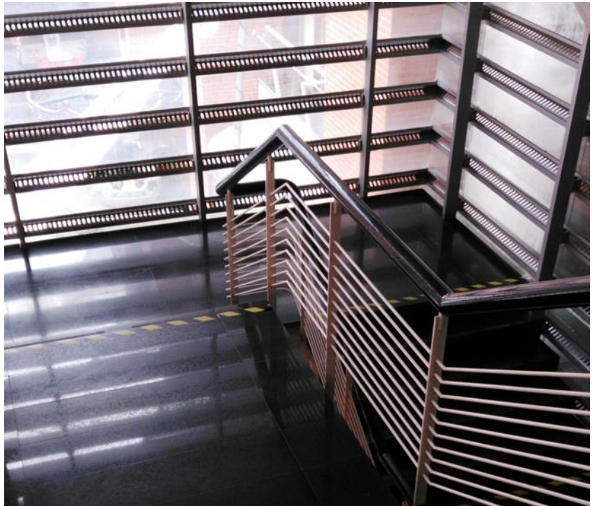
Foto 11, pavimento de escaleras
