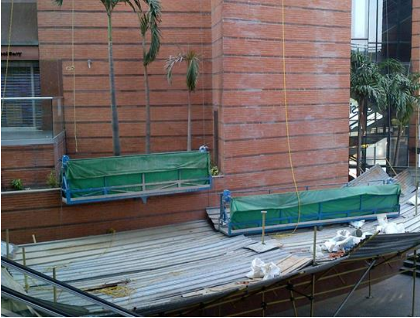
Foto 23, reparación de fachadas (Oct. 2013)
