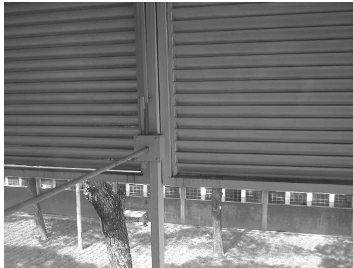
Figura 11 Detalles de protecciones solares ajustables y permeables en fachada este, ejemplo adecuado de arquitectura tropical.
