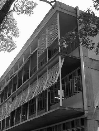
Figura 11 Detalles de protecciones solares ajustables y permeables en fachada este, ejemplo adecuado de arquitectura tropical.
