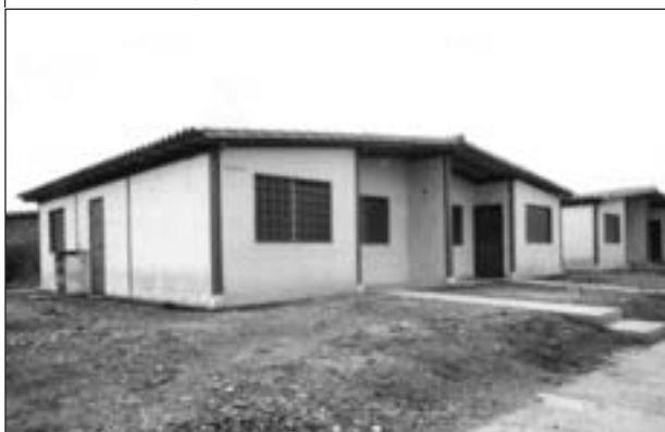
Foto 3 Estructura en perfiles metálicos
