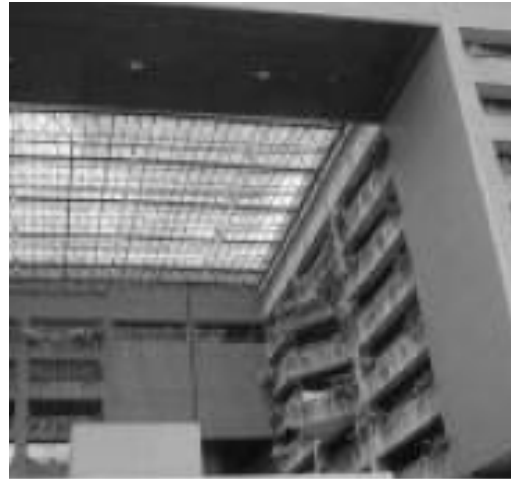
Figura 10 Gran atrio central ventilado que tamiza el calor y la luz en fachadas
