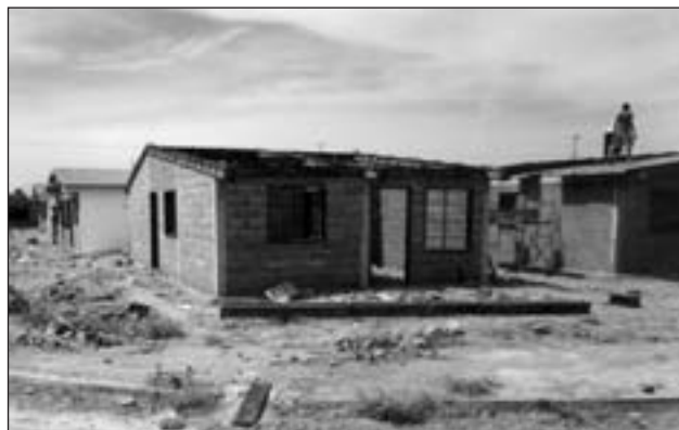
Foto 4 Estructura en concreto armado
