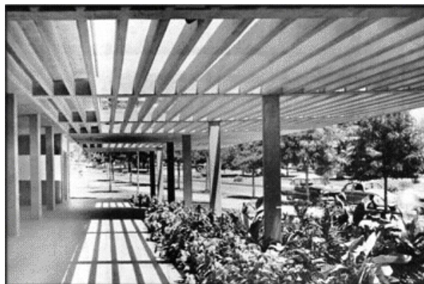
Figura 3 Uso de pérgolas para mitigar la radiación solar incidente
