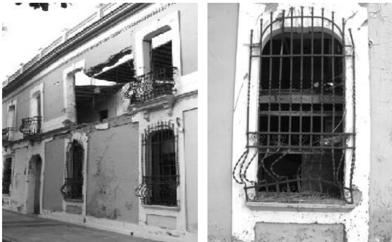
Ilustración 4.29 Daños generados en la fachada por la explosión de una bomba. Fuente: Fotos de archivo del autor.
