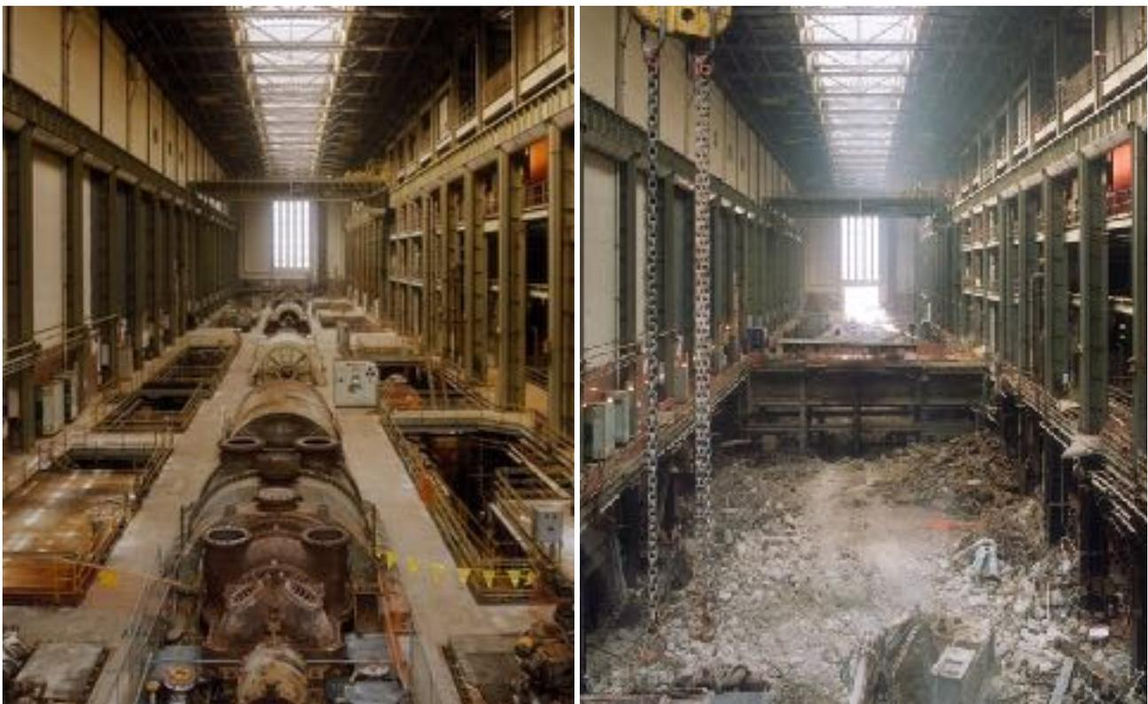
Ilustración 4.8 Demolición del interior del hall de turbinas
