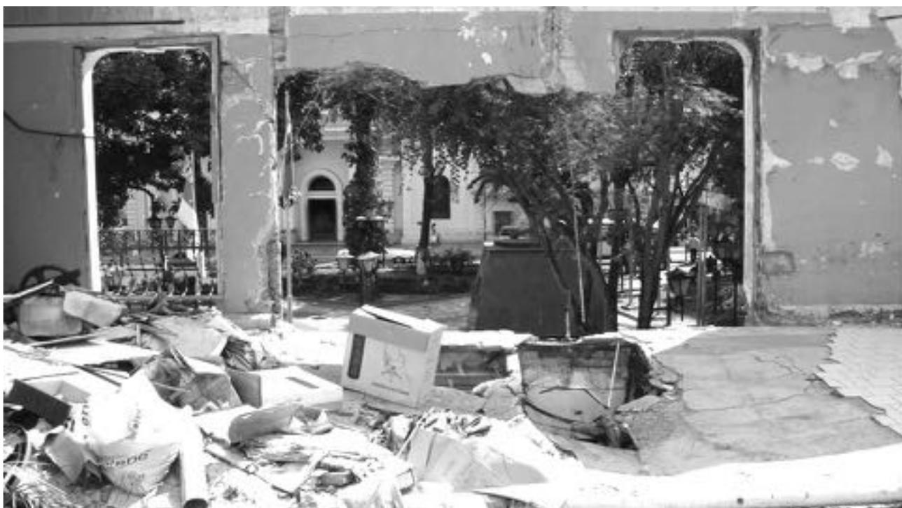
Ilustración 4.30 Daños generados en el interior del edificio por la explosión de una bomba. Fuente: Fotos de archivo del autor.
