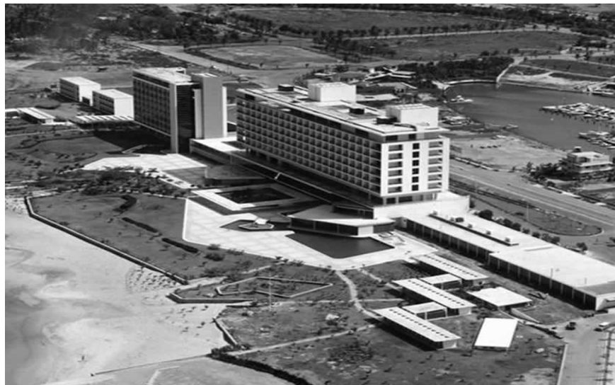
Hotel Guaicamacuto – Caraballeda Litoral Central Metropolitano. Fachada Norte.
