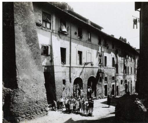
Vista de la Spina di Borgo antes de la demolición
