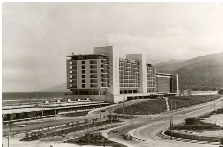
Hotel Guaicamacuto – Caraballeda Litoral Central Metropolitano. Fachada Sur
