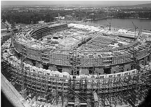
Construcción del Palacio de Congresos
