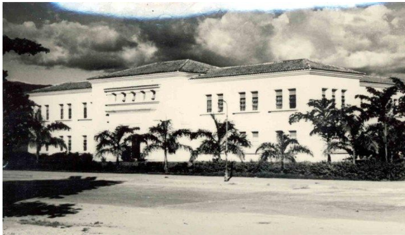
Edificio sede de la División Nacional de Malariología - 1944
