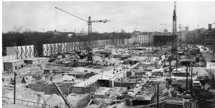
Demoliciones para el nuevo Reichstag
