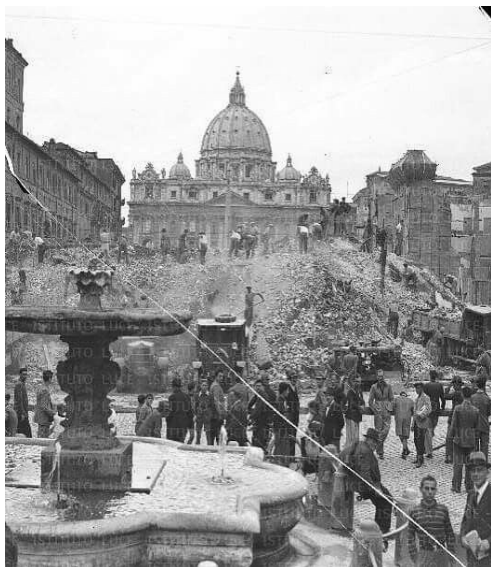
Vista de la Spina di Borgo durante la demolición
