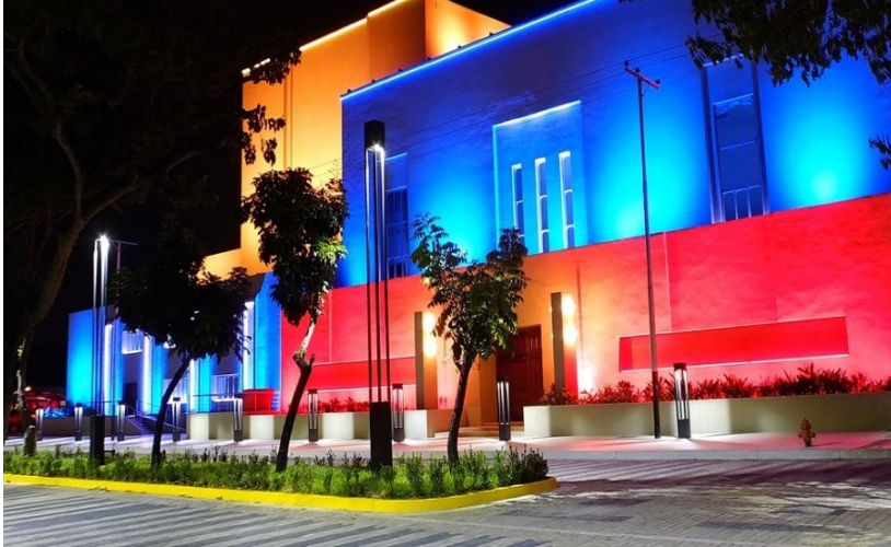
Vista nocturna del recuperado Teatro de la Opera de Maracay, con la iluminación LED - 2015
