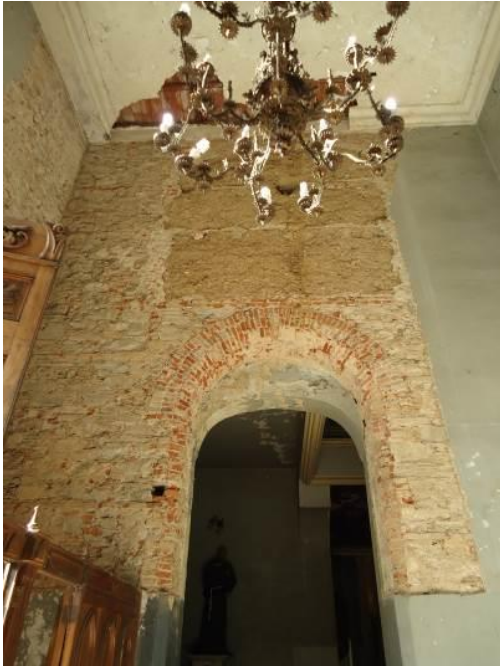
Figura 3.27: Muro norte del nártex de la nave sur.
