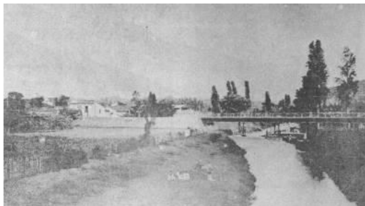
Figura 2.40: Antiguo Puente de la Constitución sobre el Guaire en la Sur 7.
