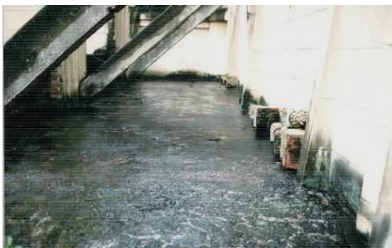
Figuras 3.26 y 3.27: Vistas de la cubierta del deambulatorio desde el techo y de las naves laterales desde el nivel de la galería. (Fuente: Pérez Gallego, 1994).
