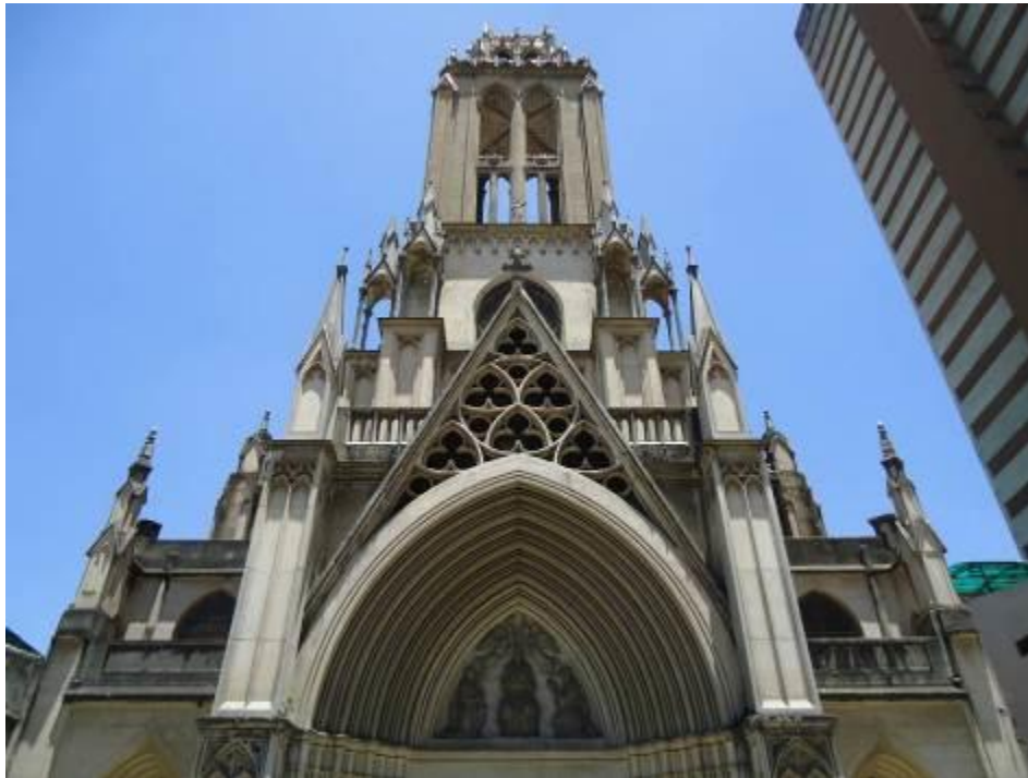
Figura 3.105: Detalle de las archivoltas y tímpano con tracerías del gablete. (Fuente: Pérez Gallego, 2012).
