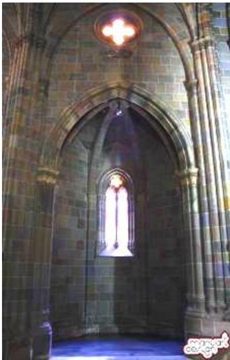
Figura 3.21: Arco ojival en la entrada de una capilla lateral. (Fuente: Lara Sánchez, 2009).
