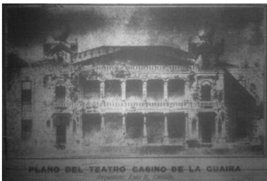
Figura 2.8: Fachada del Teatro-Casino de La Guaira. (Fuente: Castillo, 1920 en El Nuevo Diario, Caracas, 9 de enero de 1920, s.p).
