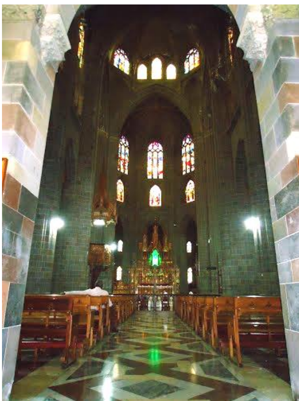
Figura 3.22: Arco ojival del sotocoro hacia la nave mayor. (Fuente: Castro, 2014).
