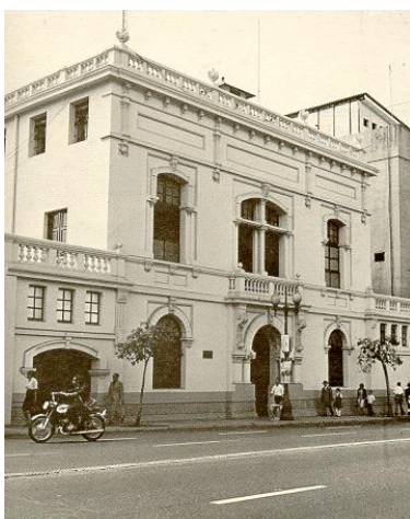
Figura 1.17: Edificio del Registro Público y Archivo Nacional. (Fuente: Anón., s.f., en Marín, 2011).
