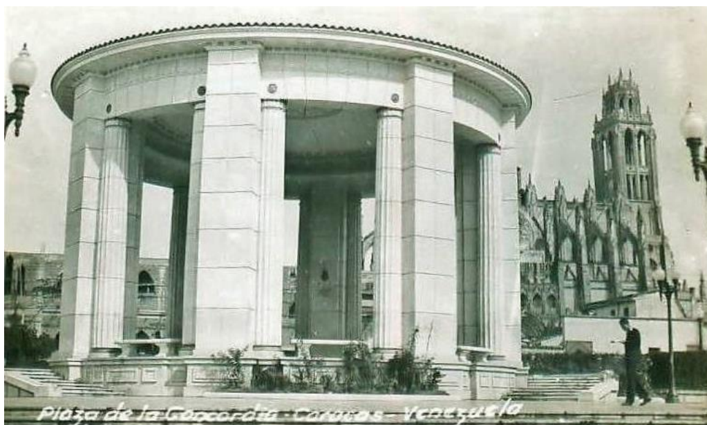
Figura 3.92: Plaza de la Concordia, Caracas. Al fondo despunta la torre del Santuario Nacional Expiatorio y el convento de Las Siervas en proceso de construcción. (Fuente: Anón., s.f. [1945 c.], en Sigillo, 2012).
