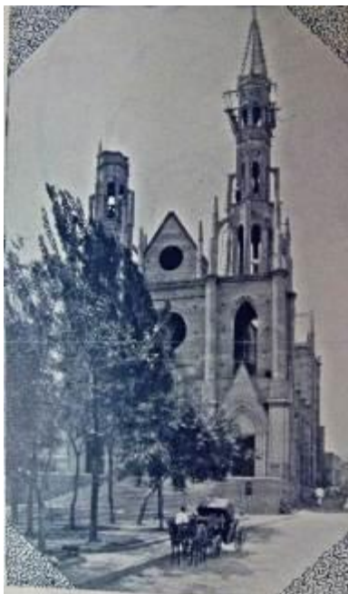
Figura 3.3: Iglesia de la Inmaculada Concepción en construcción. (Fuente: Avilán, s.f., en Élite, 19 de febrero de 1927).
