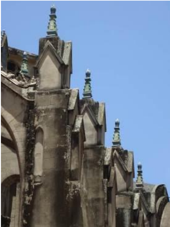
Figuras 3.75: Detalle de los pináculos de arcilla vidriada que rematan los contrafuertes. (Fuente: Pérez Gallego, 2012).
