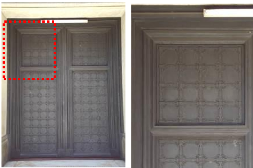
Figuras 3.77 y 3.78: Puerta del acceso principal y detalle de los relieves aplicados de en herrería. (Fuente: Pérez Gallego, 2012).
