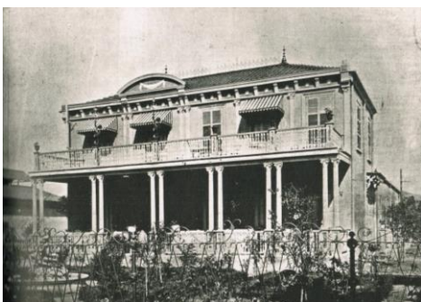
Figura 1.16: Villa de Carlos Zuloaga en El Paraíso. (Fuente: Burgos, 1901, en El Cojo Ilustrado, 15 septiembre de 1901).
