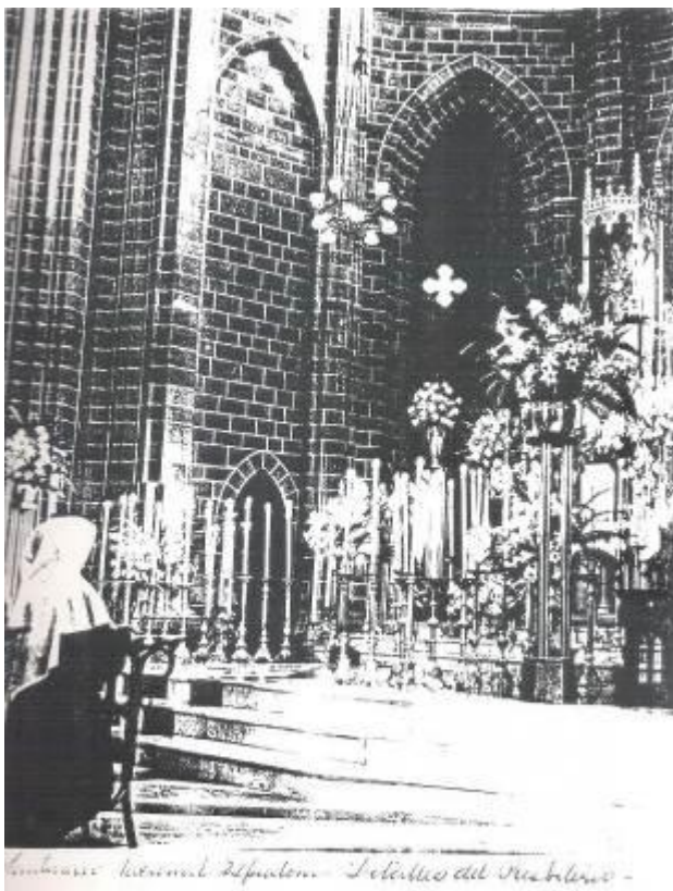
Figuras 3.74: Detalle del presbiterio donde se aprecia el estuco catalán simulando falsa sillería. (Fuente: Anón., s.f. [1940 c], en Archivo Siervas del Santísimo Sacramento).
