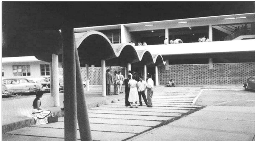
Figura 10. Edificio de Aulas Luis Daminani en 1959.
