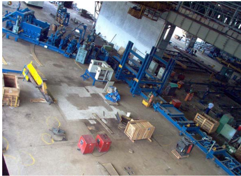
Figura 22 - Vista general de la Máquina recién montada.
