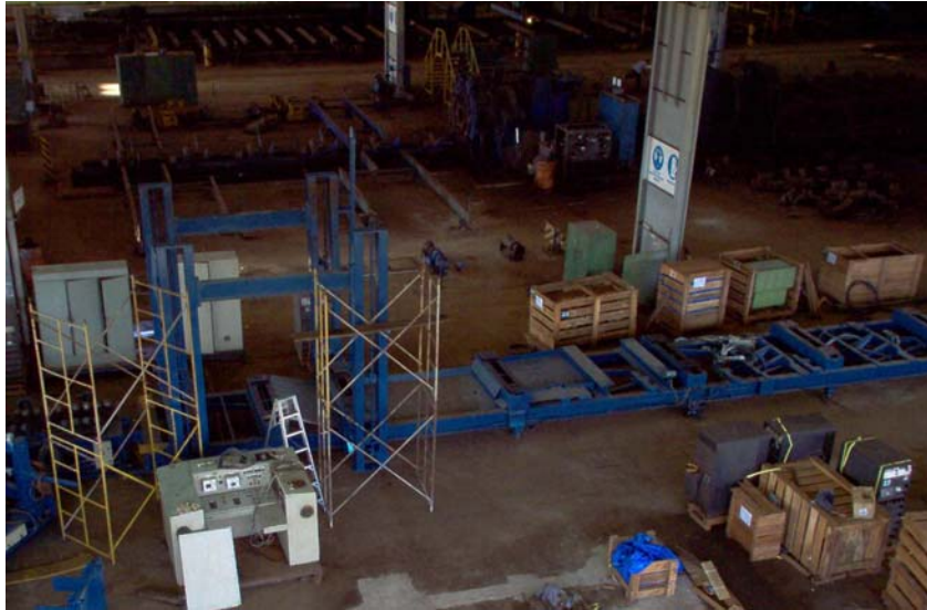
Figura 17 - Detalle del Montaje del Pórtico sobre la Sección C del Bastidor de Salida.
