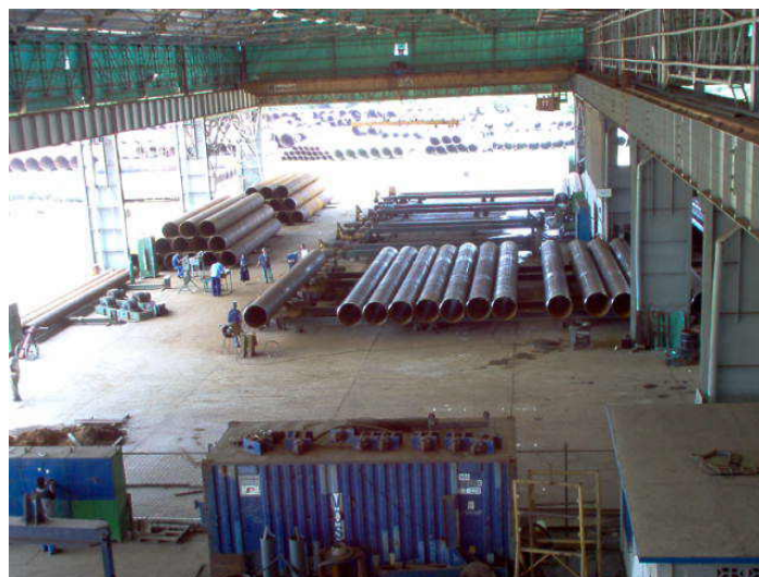
Figura 6 - Zona de despacho antes de iniciar el acondicionamiento.
