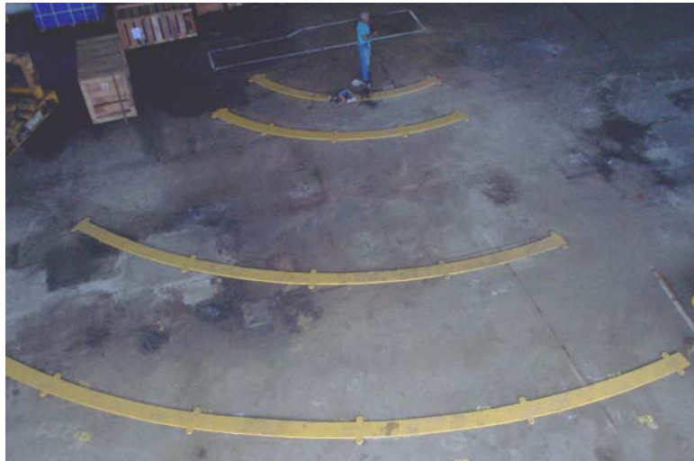
Figura 11 - Montaje de los Rieles del Bastidor de Entrada
