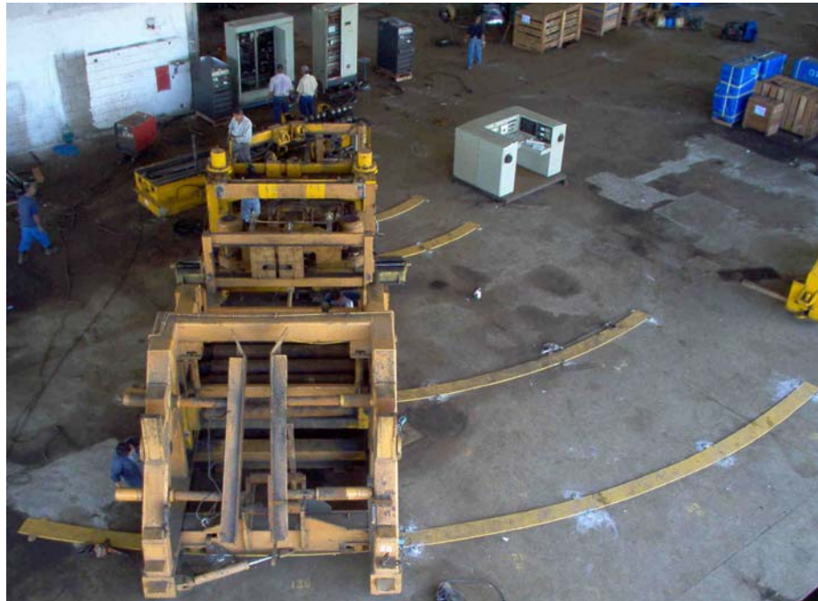
Figura 13 - Montaje de la sección B del Bastidor de Entrada
