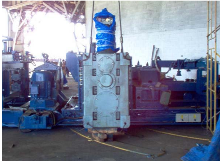
Figura 19 - Montaje de los Reductores de los Rodillos de Tracción
