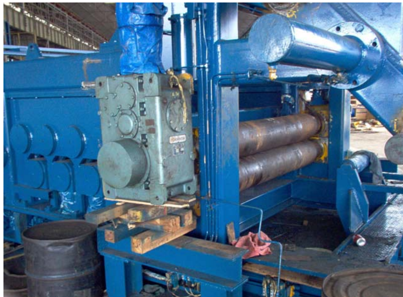
Figura 18 - Rodillos de Alimentación ya instalados.
