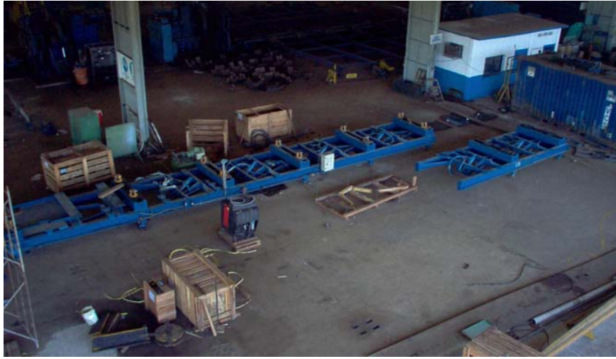
Figura 21 - Imagen de las Secciones D y E del Bastidor de Salida.
