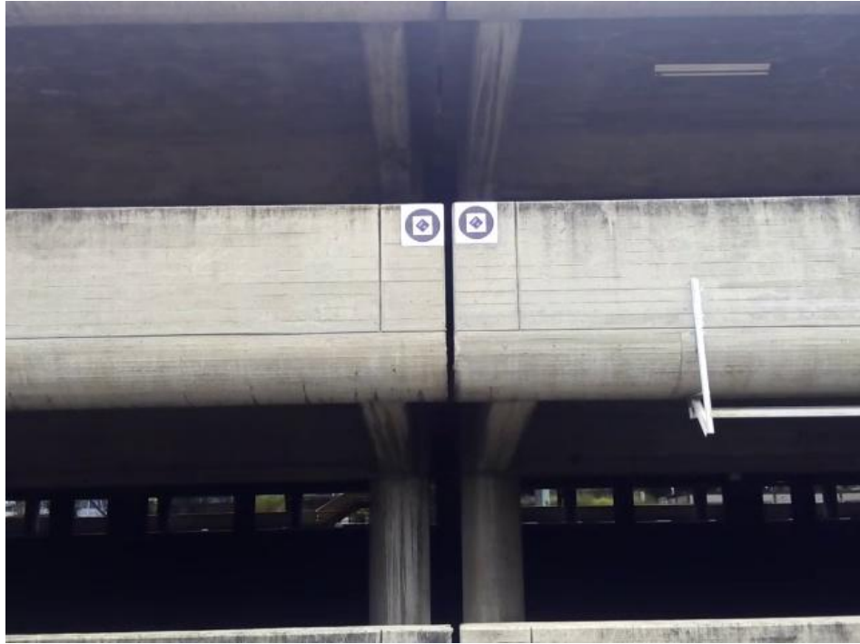
Figura 29 Estacionamiento Estructural de la Ciudad Universitaria de Caracas.
