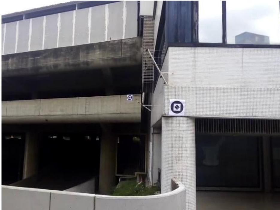
Figura 30 Edificios del I.P.P. y estacionamiento estructural de la Ciudad Universitaria de Caracas.
