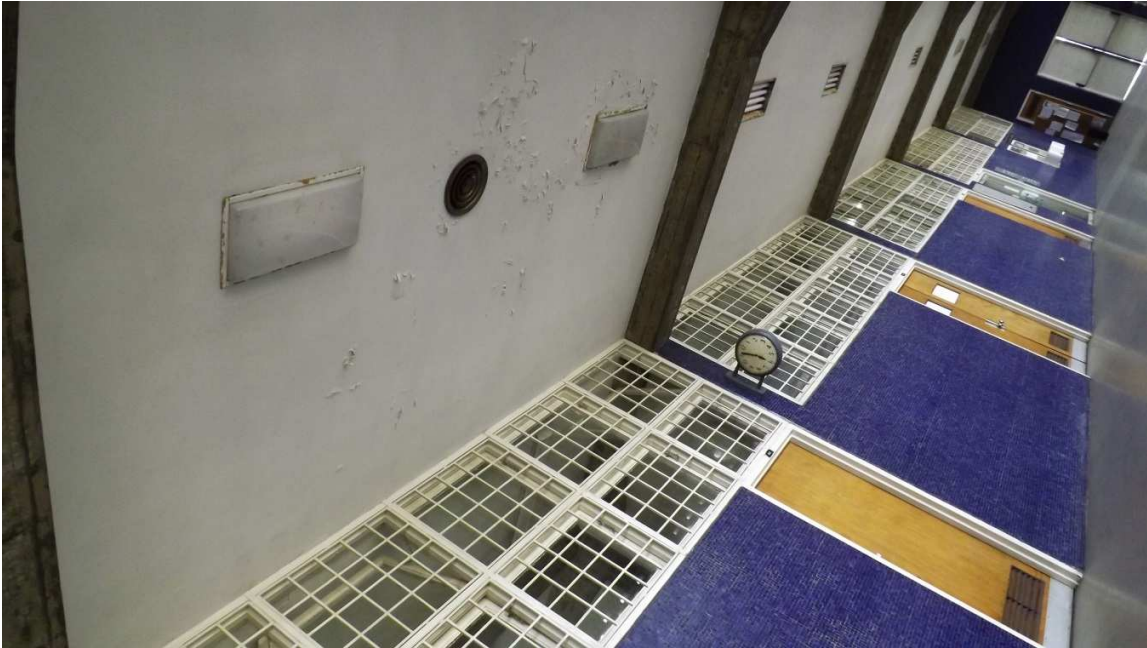
Fotografía 4-4 Difusor de sonido. Pasillo del piso 8 del conjunto de la FAU Autor: Yoisy Rangel, 2015
