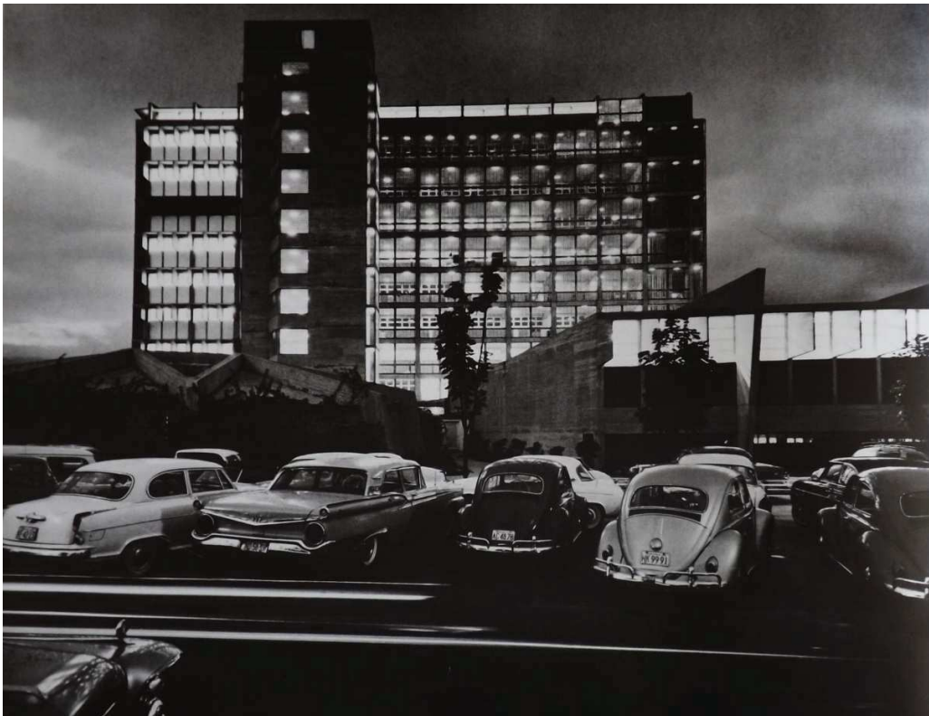
Fotografía 2-5 Vista Nocturna de la fachada sur de la Facultad de Arquitectura y Urbanismo Fuente: Un moderno en Venezuela , Galería de Arte Nacional 2000, pág 214
