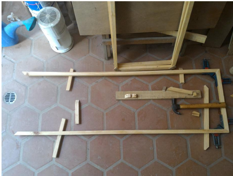
Figura 6.1: En la foto se muestra la forma en la que fue armado cada marco los mismos tienen un Angulo de 90 grados en cada esquina y su forma es rectangular, para garantizar que mantuvieran esta forma se uso pega y clavos,
