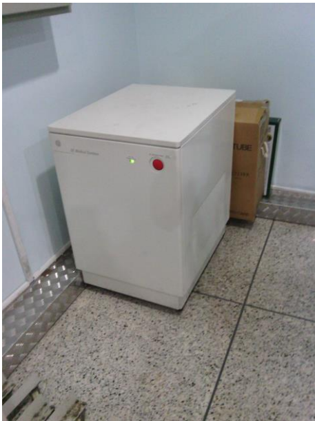
Figura 2.7: transformador de alto voltaje.
