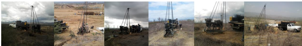
Figura 5.2. Zona de estudio y ubicación de las perforaciones.
