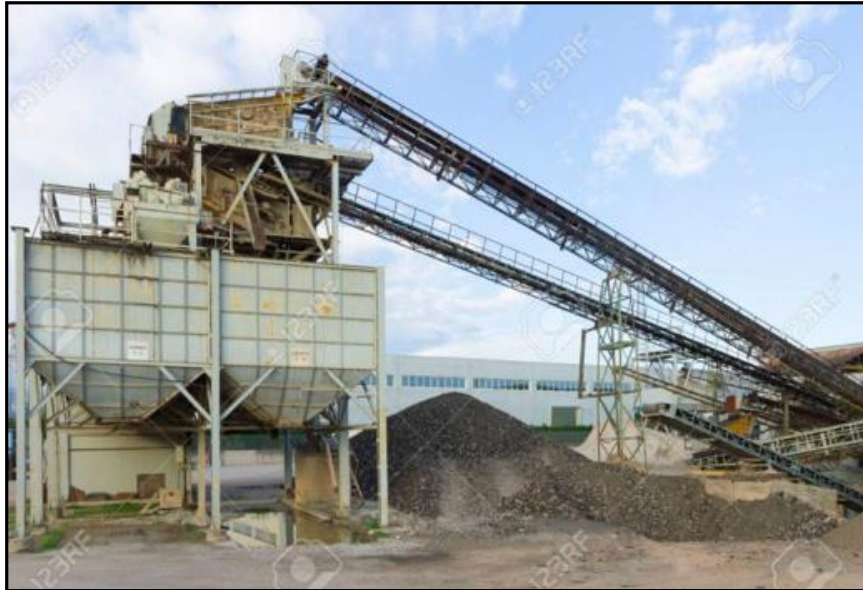
Figura n° 11 Cinta transportadora. Fuente: 123RF. Foto de archivo- Mina de piedra con los silos y cintas transportadora. Equipo industria. Minería
