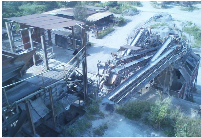
Figura 15. Planta de beneficio mineral, Cantera La Ceiba, Vista sur.
