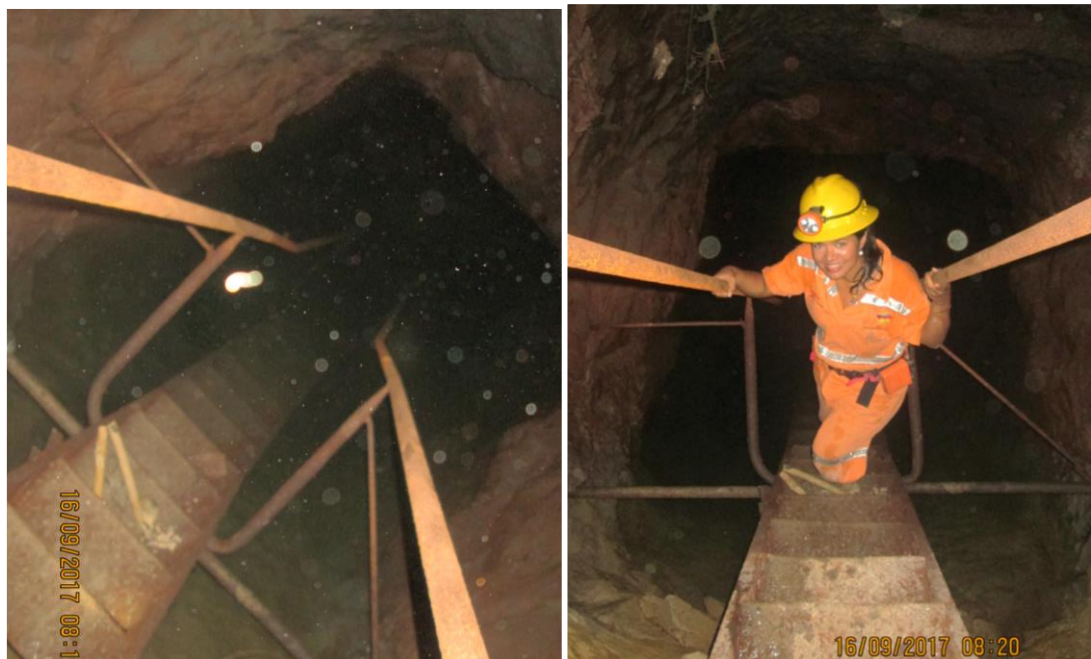
Figura 4.6. Nivel de inundación en chimenea de traspase del nivel 4 al nivel 5. Fuente: Elaboración propia.
