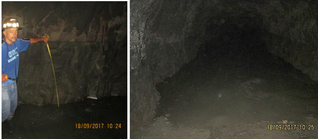
Figura 4.5. Nivel de inundación en rampa del nivel 4 al nivel 5. Fuente: Elaboración propia.
