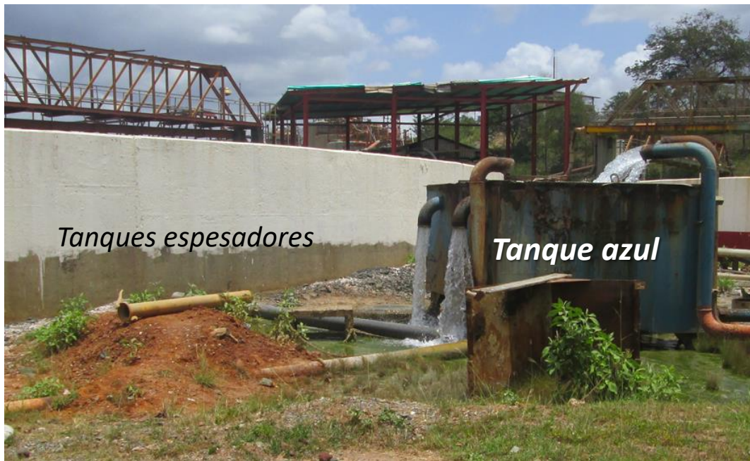
Figura 5.14. Descarga en superficie de la estación de bombeo del nivel 1. Fuente: Elaboración Propia.
