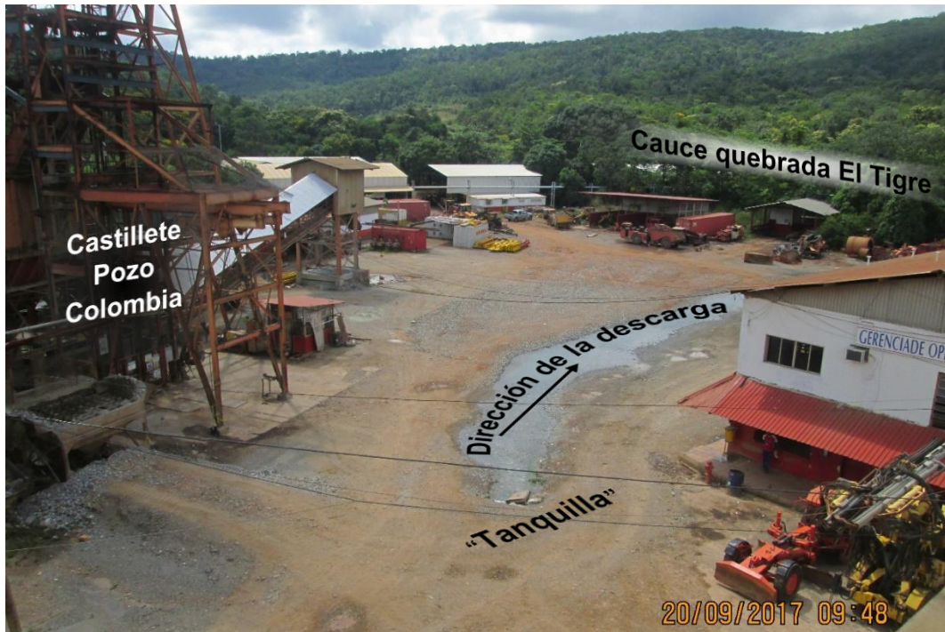
Figura 5.13. Descarga en superficie de la estación de bombeo del nivel 4. Fuente: Elaboración Propia.
