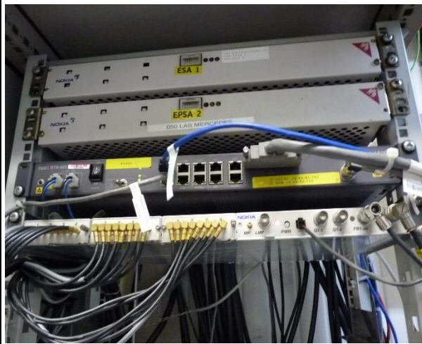
Rack N-2 En donde se encuentra el PDU en donde se tomará la Energía para el Switch
