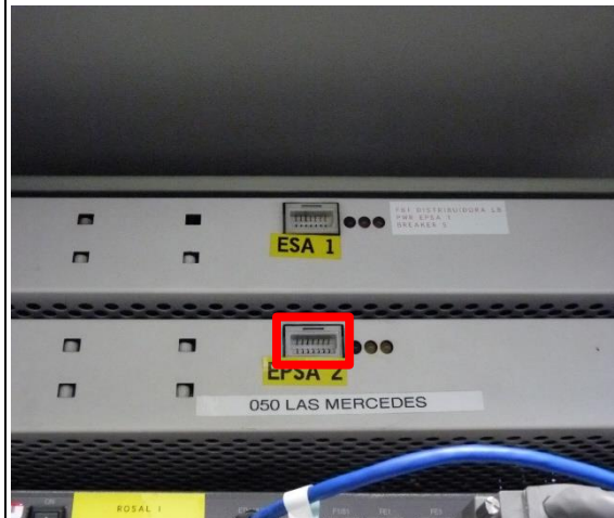
Vista Cercana del EPSA 2 de donde se tomará la Energía para el Switch Corporativo.
