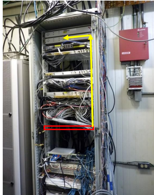
Vista Cercana del EPSA 2 de donde se tomará la Energía para el Switch Corporativo.
