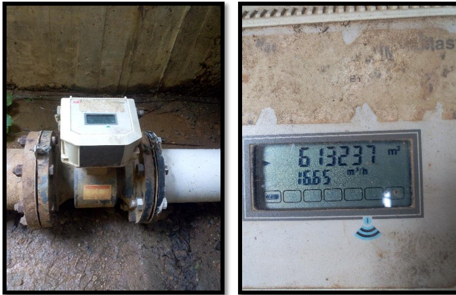
Figura B1. Lado izquierdo: Imagen del medidor de agua N° V413891-32. Lado derecho: lectura tomada el día 15-07-2016. Fuente: Elaboración propia.
