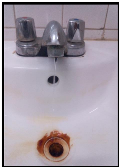
Figura F2. Imágenes del estado actual de las piezas sanitarias. Lavamanos con fuga y poceta fuera de servicio. Fuente: Elaboración propia
