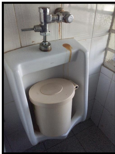
Figura F1. Imágenes del estado actual de las piezas sanitarias. Poceta con fuga y Urinario fuera de servicio. Fuente: Elaboración propia
