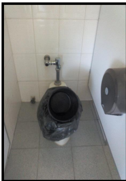
Figura F2. Imágenes del estado actual de las piezas sanitarias. Lavamanos con fuga y poceta fuera de servicio. Fuente: Elaboración propia
