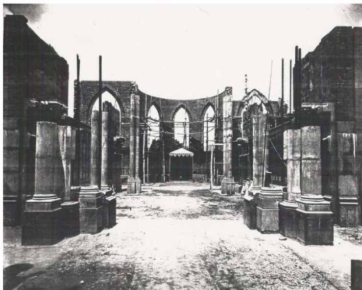
Obras del Santuario Nacional Expiatorio (1925 c.)
