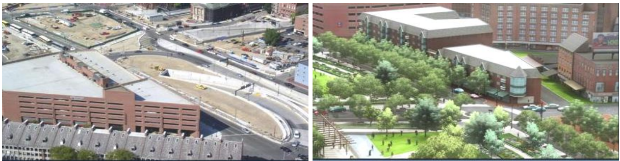
Imagen 55: Vista de la obra ejecutada y de la propuesta
