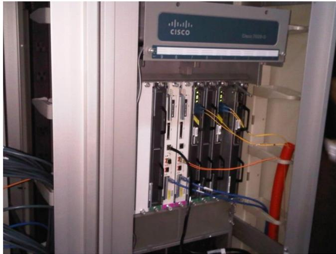
**Figura 21. Router Serie 7600 con la tarjeta ME instalada.**
