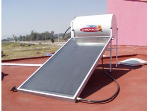
Figura 2.10. Calentador solar termosifónico con colector tipo caja plana y termotanque de almacenamiento. (Mundo Solar 2012).
