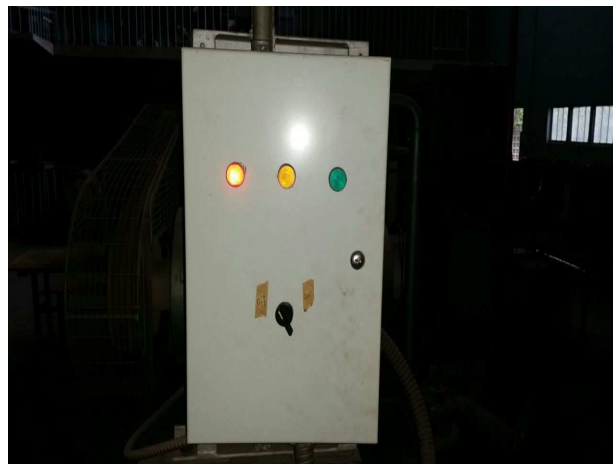
Figura 5.18: Cajeta de circuito de potencia cerrada del compresor
