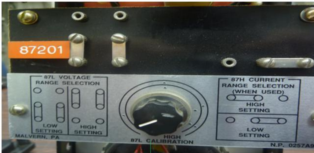
CALIBRACION DE LA UNIDAD 87L
