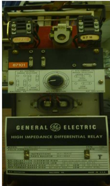
Figura 68: Relé diferencial GE de alta impedancia PVD21
