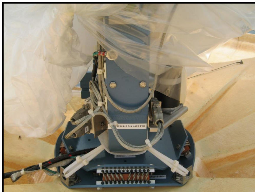
Remoción de los precintos de seguridad.
