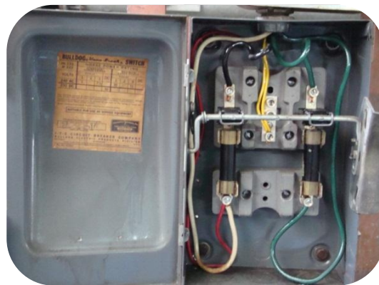
Foto. 5. Parte interna de la fusilera del motor.
