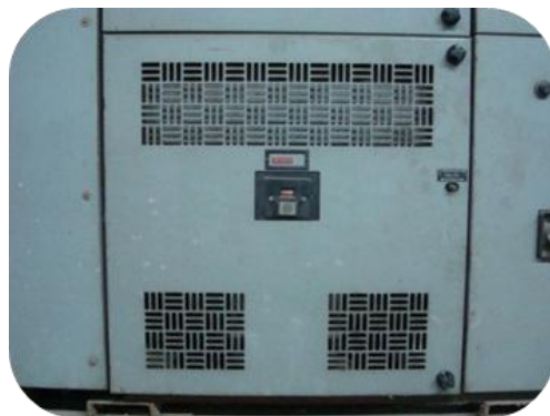
Foto. 22. Interruptor principal del C.C.D.P.
