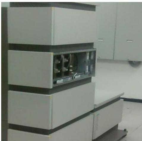
**Imagen 5: Central telefónica Siemens-Hipath 4000. Tarjetas Digitales E1. SICODENA área central.**
