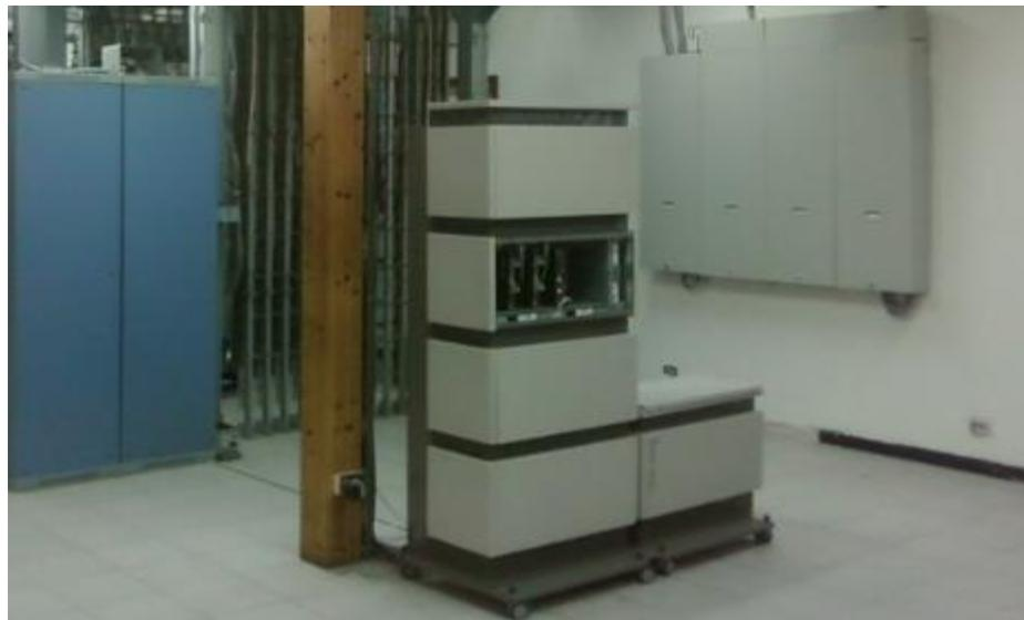
**Imagen 2: Módulos central Siemens-Hipath 4000 y equipos de transmisión.
