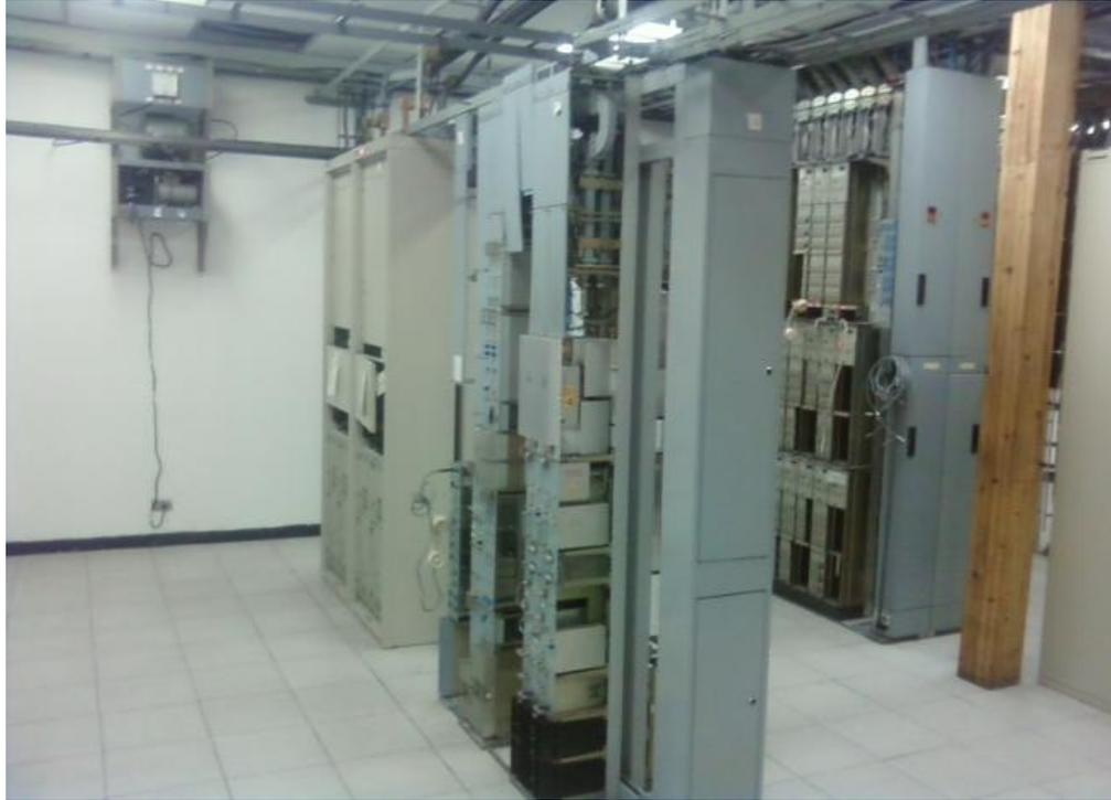
**Imagen 3: Módulos de equipos de radio enlaces y circuito híbrido
