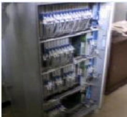
**Imagen 7: Sección del módulo 5 central Ericsson MD-110 BC del EJNB. Central telefónica Comandancia General del Ejército.**
