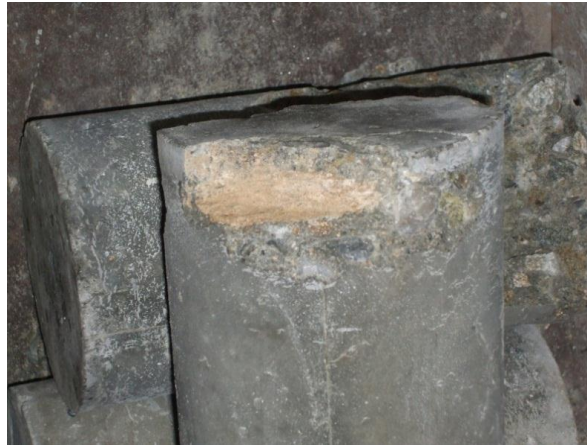
Figura N ° 17: Falla por agregado.
