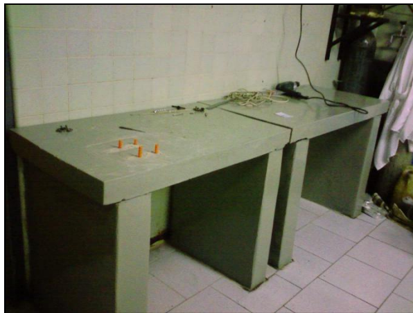
Figura N°37. Instalación de las bombas JR104A-Madden®
