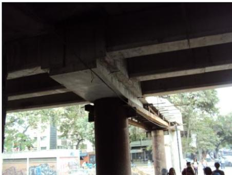
**Figura No 19.** Malas terminaciones en la parte inferior de la ampliación ejecutada a la altura del Puente Bellas Artes al frente del barrio Los Chaguaramos.
