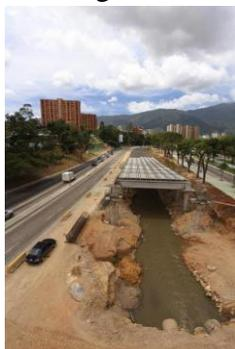
**Figura No 15.** Destrozos al embaulamiento por obras de ampliación en el río El Valle vistas desde la Bandera cruce con Paseo Los Ilustres.
