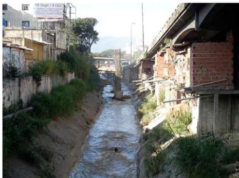
**Figura No 13.** Daños ocasionados al embaulamiento por columnas en el río El Valle vistas desde la Av. Bellas Artes cruce con Av. La Facultad.
