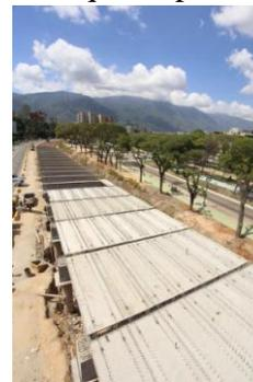
**Figura No 16.** Resultado de la cobertura aplicada al cauce del río El Valle, a la altura del Paseo Los Ilustres..
