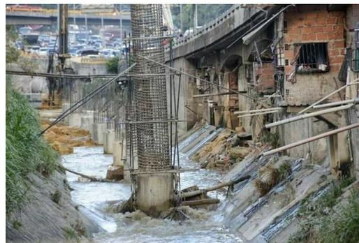
**Figura No 14.** Daños ocasionados al embaulamiento por columnas en el río El Valle vistas desde la Av. Bellas Artes cruce con Av. La Facultad.
