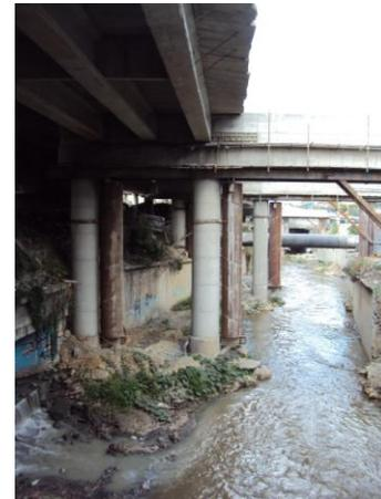
**Figura No 22.** Detalles de malos acabados y daños ocasionados al embaulamiento por columnas en el río El Valle vistas desde el puente Bellas Artes cruce con Av. La Facultad.
