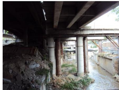
**Figura No 20.** Malas terminaciones en los elementos estructurales de la ampliación ejecutada a la altura de la avenida La Facultad – Los Chaguaramos
