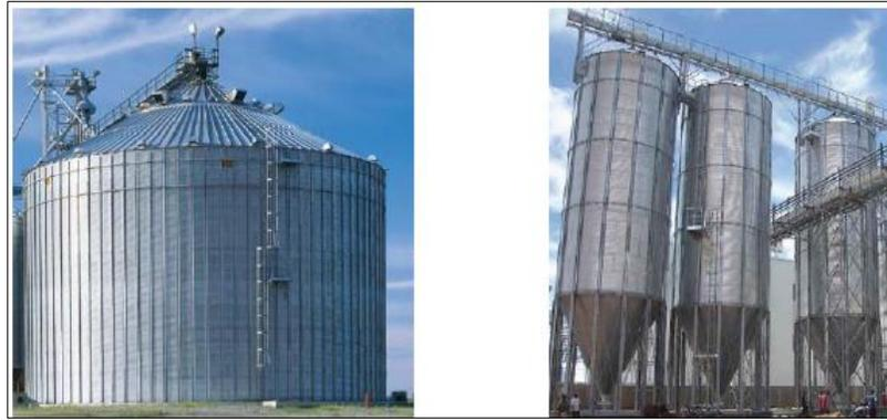
**Figura 16.** Silo convencional (fondo plano), izquierda, y silos tolva (hopper silos), derecha. Fuente: (García, 2005).
