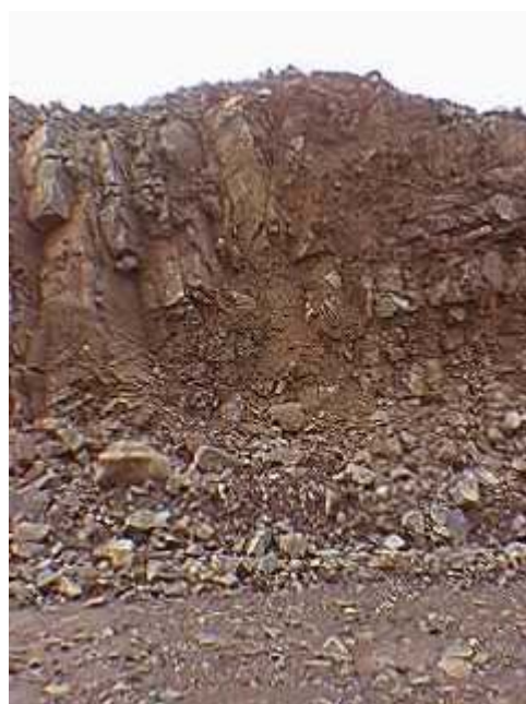
Fig. 59. Frente de Excavación Unidad 4
