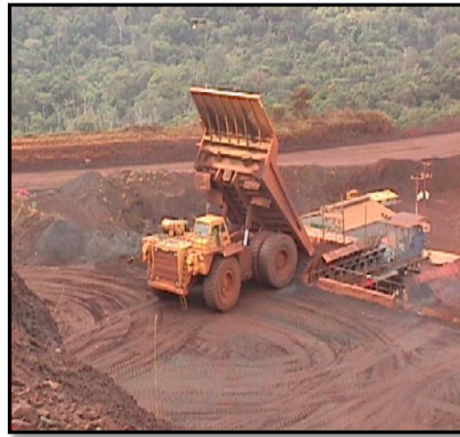
Figura 3.16 Camión descargando en PTLB.
