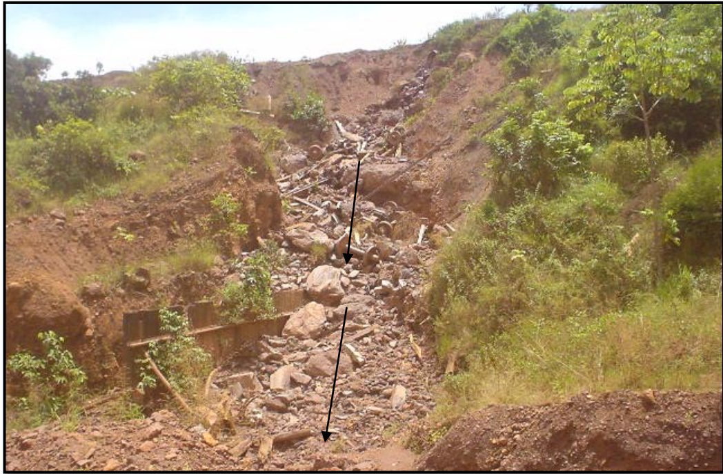
Figura 5.11 Vista de una cárcava en SI.
