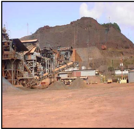
Figura 3.15 Vista de PTLB.
