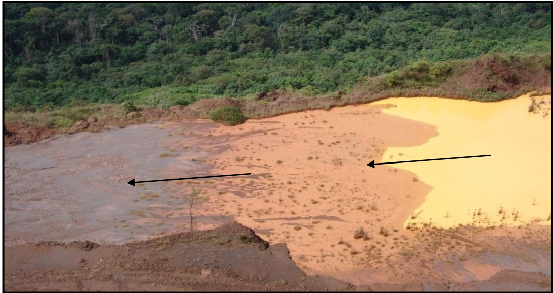
Figura 5.14 Vista de dique en la ladera sur de LB
