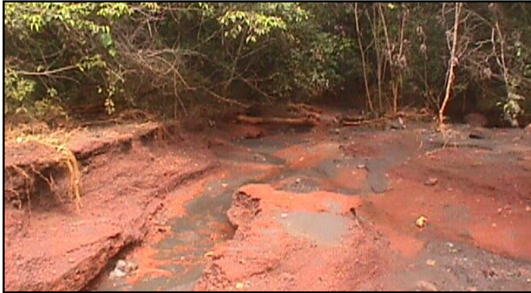
Figura 5.12 Acumulación de sedimentos en el lecho de la quebrada Arasiama.
