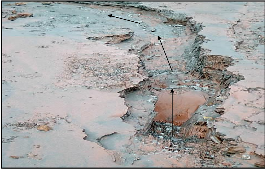
Figura 5.10 Vista del proceso de formación de una cárcava en SI.
