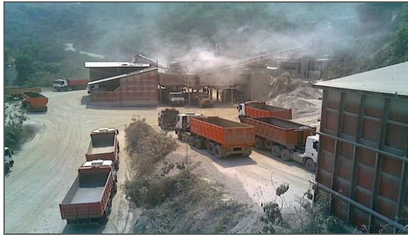
Foto 5.2. Tolvas de despacho de producto final
