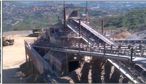
Foto 5.10. Planta 2. Fotografía propia
