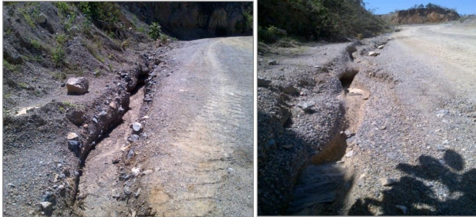
Foto 6.3. Drenajes en las vías internas de la Cantera
