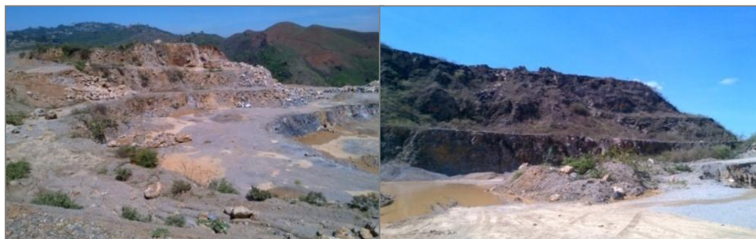
Foto 6.2. Taludes bien conformados de los sectores C y D. Fotografías propias
