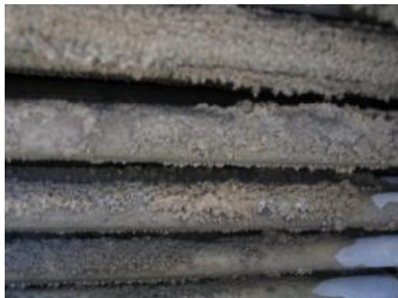
**Figura N°19:** Imagen de los tubos inferiores del condensador evaporativo con incrustaciones.
