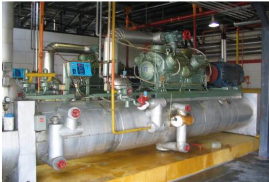
**Figura N°7: Sistema Evaporador – Compresor.**
