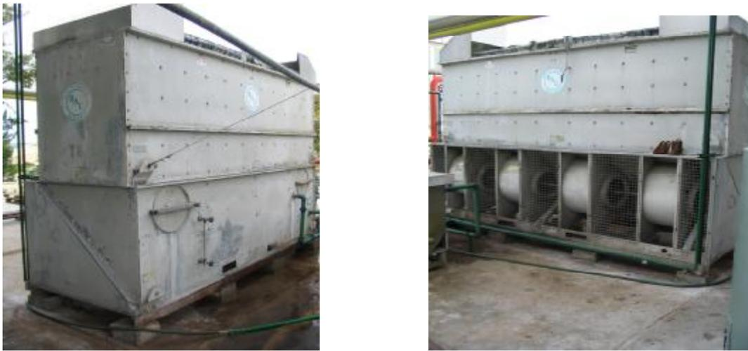
**Figura N°13:** Vista lateral derecha y lateral izquierda de un condensador evaporativo.
