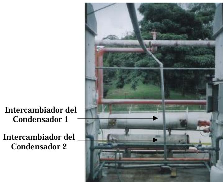
**Figura N°12:** Intercambiadores de calor empleados por los condensadores para eliminar el sobrecalentamiento. Componente adicional de los condensadores.
