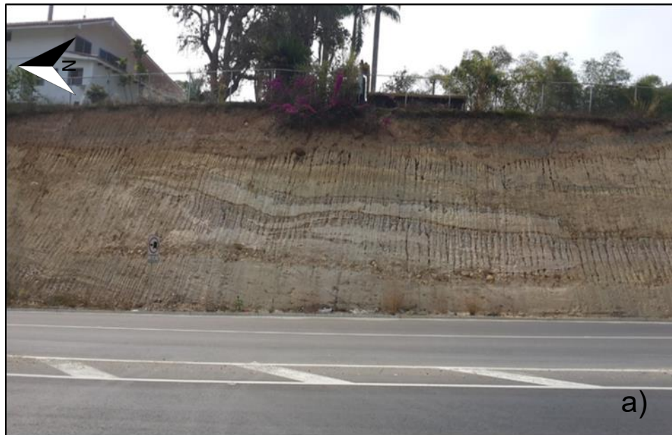
Figura 52. a) Fotografía Talud 2 (Vista de frente).
