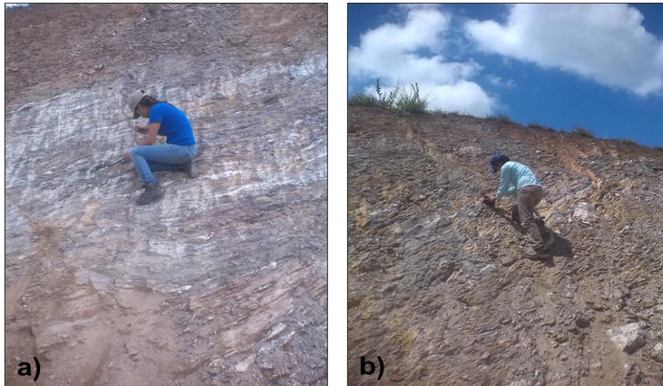
Figura 20. a) Parte alta de uno de los taludes de la zona, se observa un Esquisto calcítico – moscovítico con dos direcciones de diaclasas. b) En el tope del talud se observa una delgada capa vegetal, así como el color meteorizado anaranjado en algunas áreas del afloramiento.
