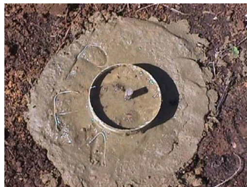
Figura 5 Demarcación de las calicatas
