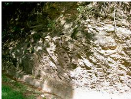
Figura 16. Fotografía del afloramiento # 7 Patrón de diaclasas
