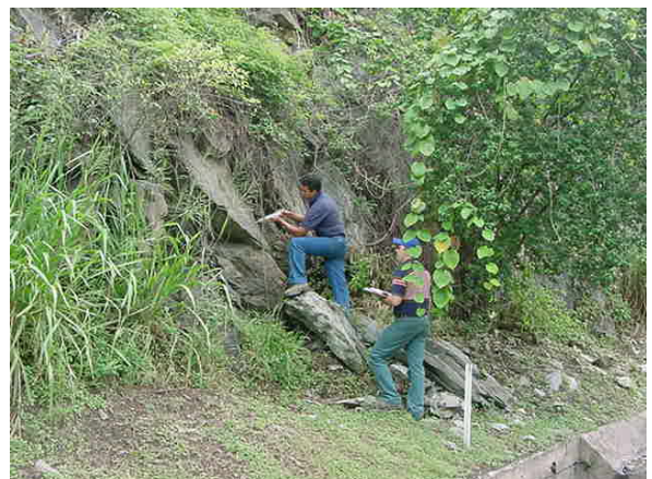
Foto 9. Vista de diaclasas del Talud # 9
