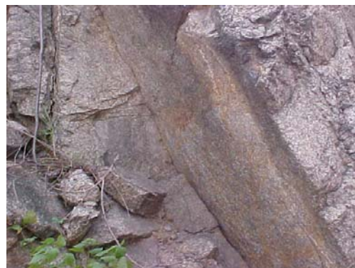
Foto 17. Vista de diaclasas del Talud # 24
