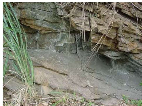
Foto 6. Vista de diaclasas del Talud # 5
