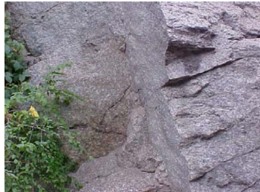
Foto 25. Vista de diaclasas del Talud # 40
