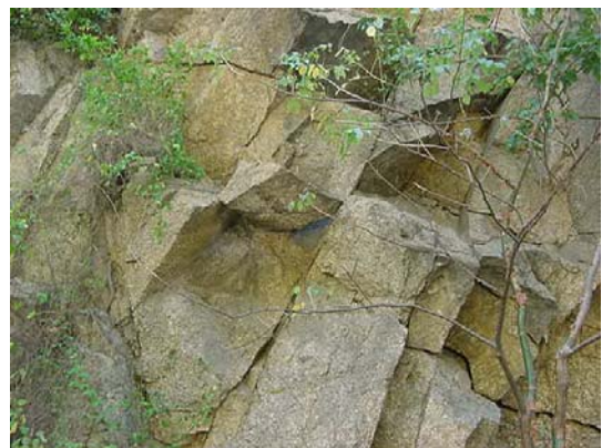
Foto 29. Vista de diaclasas del Talud # 48
