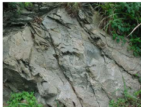
Foto 5. Vista de diaclasas del Talud # 3
