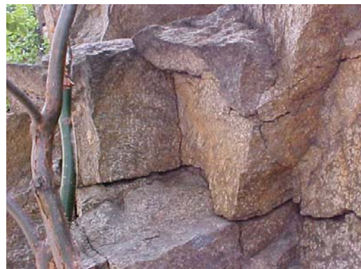
Foto 20. Vista de diaclasas del Talud # 30
