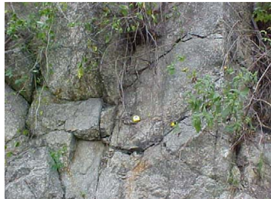
Foto 19. Vista de diaclasas del Talud # 27
