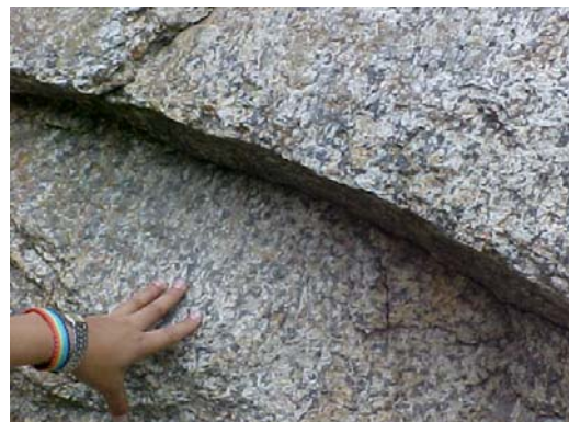
Foto 21. Vista de diaclasas del Talud # 31
