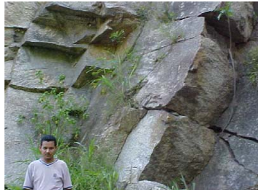
Foto 13. Vista de diaclasas del Talud # 17
