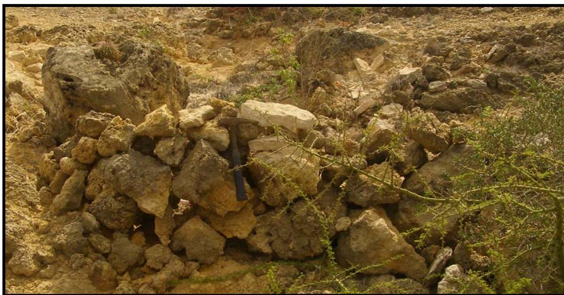
**Figura 34.** Pequeña presa construida en la zona de Cautaro con bloques de la Formación Tortuga.
