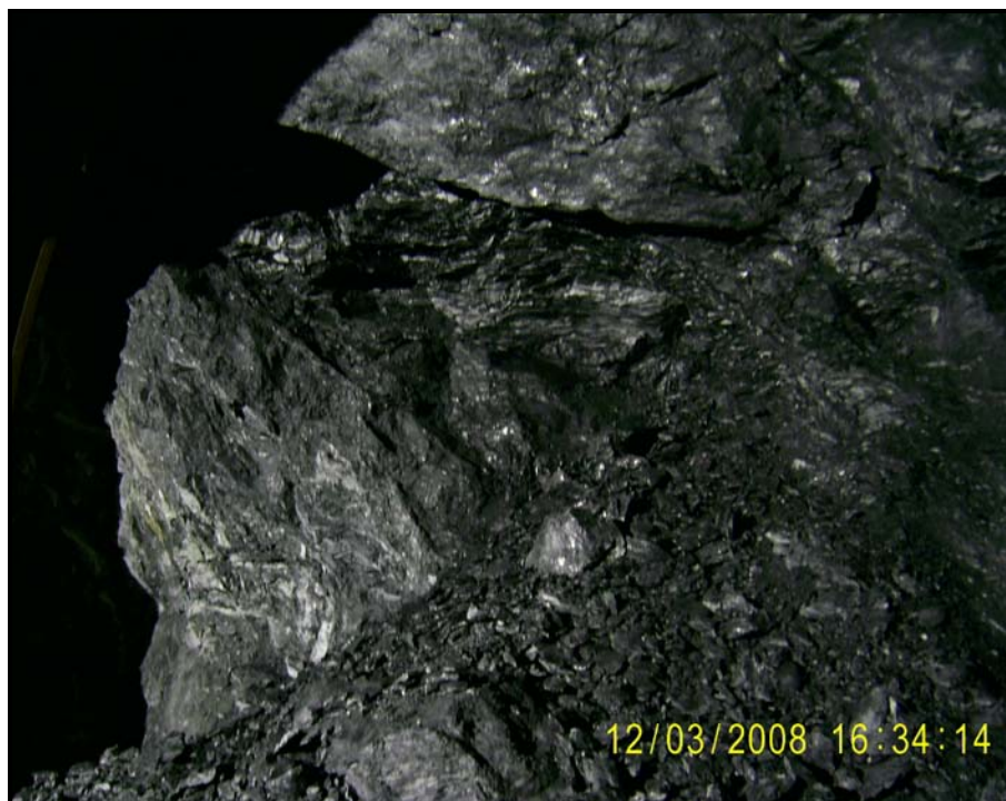
Figura 9.24. Frente de excavación Túnel Tránsito Taguaiguay-Valles de Tucutunemo. Filita Grafítica. Tomada por: Rosangela Martínez. (2008).
