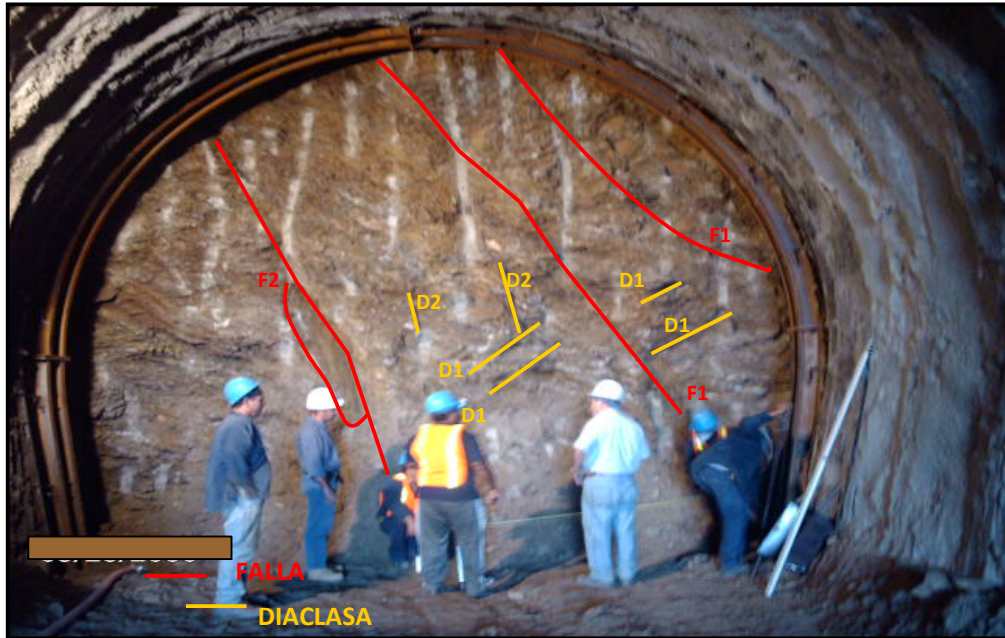
Figura 9.42. Vista de las discontinuidades del frente de excavación. Fallas y diaclasas resaltadas. Progresiva 0+033.6. Tomada por: Maira Hernández (2007)
