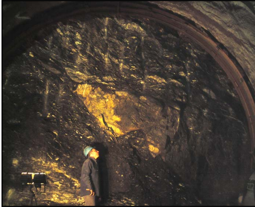
Figura 9.27. Disposición del bloque de meta-arenisca en el frente de excavación. Progresiva 0+102.75. Tomada por: Rosangela Martínez (2008)
