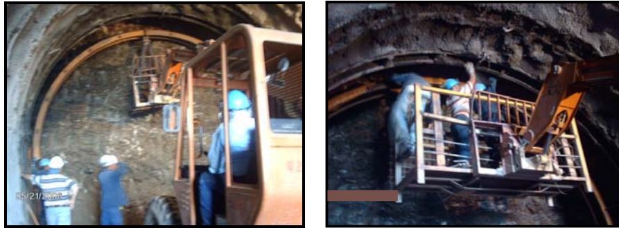
Figura 7.2. Colocación de Costillas. Túnel trasvase Taguaguay-Valles de Tucutunemo.
