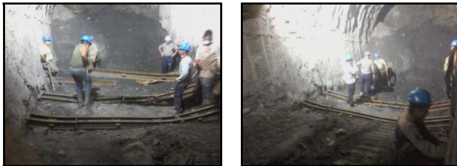
Figura 7.7. Colocación de arco invertido como medida de seguridad.
