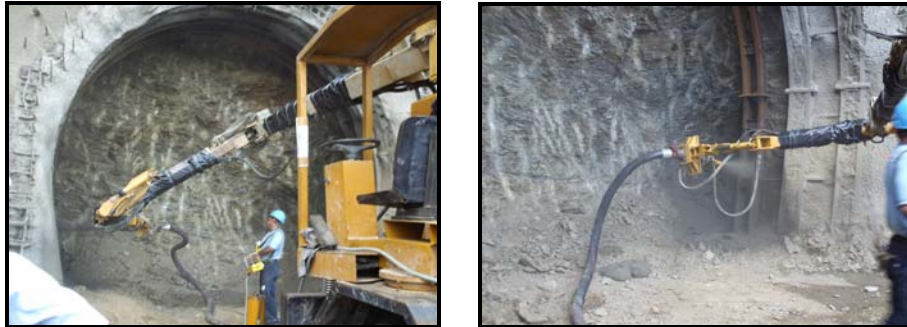
Figura 7.5. Aplicación del concreto proyectado en el Túnel trasvase Taguaguay-Valles de Tucutunemo. Tomada por: Rosangela Martínez. 2008
