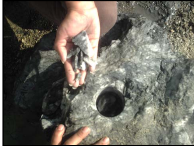
Figura 9.55. Fractura del material rocoso en la excavación del túnel. Tomada por Maira Hernández (2008)
