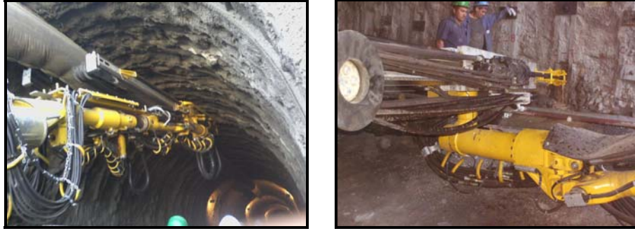
Figura 7.6. Colocación de swellex en el túnel trasvase Taguiguay-Valles de Tucutunemo.
