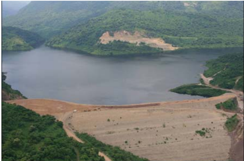
Figura 5. Presa de materiales sueltos El Diluvio, estado Zulia.
