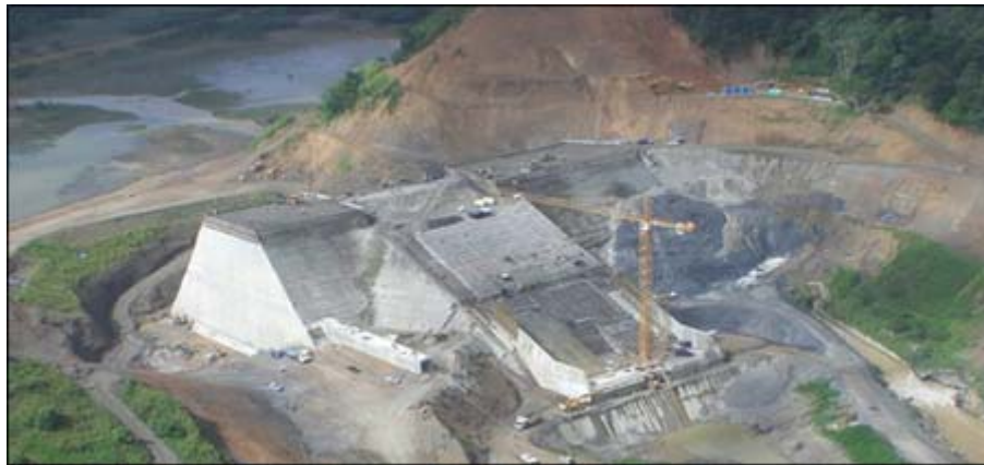
Figura 13. Presa de RCC El Guapo, estado Miranda
