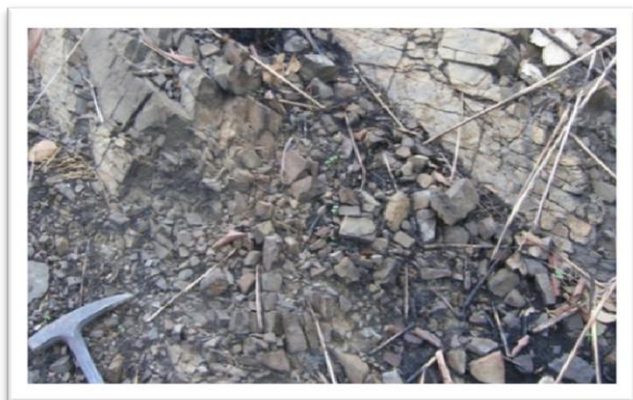
Figura C31. Areniscas fuertemente diaclasadas y fracturadas.
