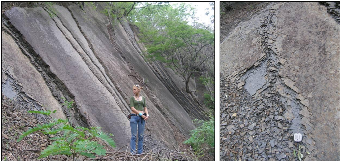
Figura 55. Afloramientos vistos a lo largo de la carretera Altagracia de Orituco-Guatopo, donde las lutitas de color gris oscuro verdosas predominan sobre las areniscas, y presentan fuerte diaclasamiento.
