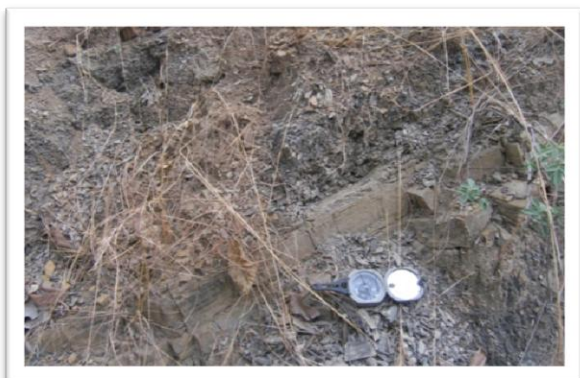
Figura C28. Afloramiento moderadamente cubierto, se observan capas de areniscas y lutita muy fracturada.
