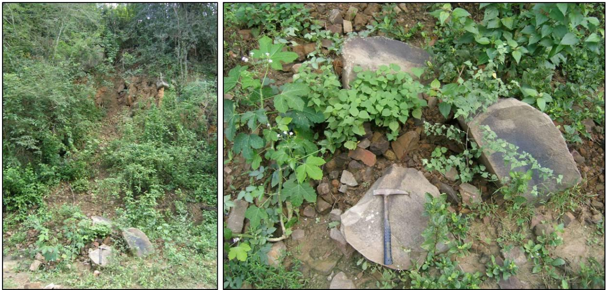
Figura 61. Bloques de arenisca caídos desde el tope del talud por un pequeño derrumbe. El afloramiento está cercano a la represa a 4 km al suroeste de Boca de Uchire.
