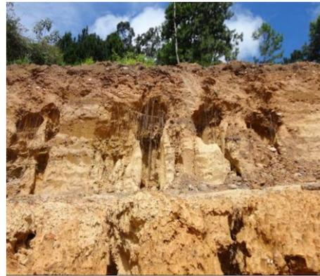
Figura N° 55. Erosión en taludes y vías excavadas en el rango de dos meses.
