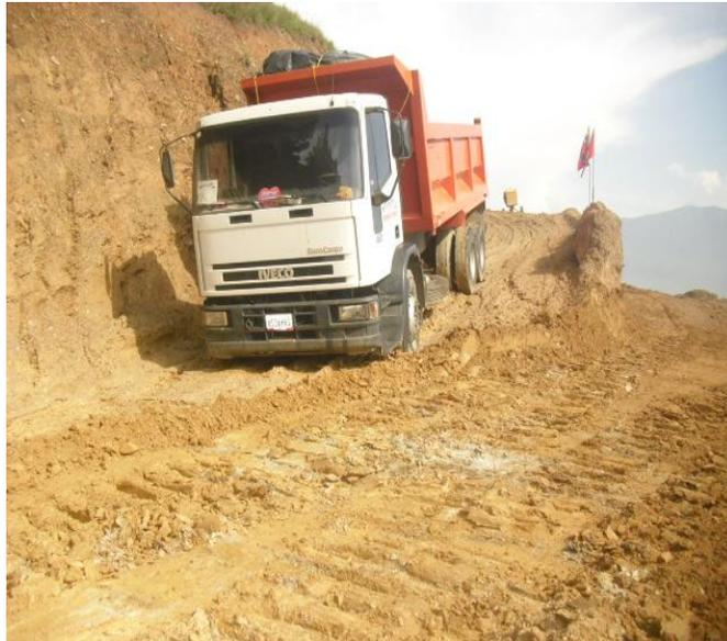
Figura N° 111. Colocación del Material de Relleno / Topografía.
