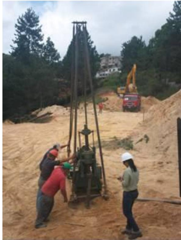
Figura N° 6. Maquina de perforación, utilizada en el sitio estudiado, siendo trasladada a la siguiente perforación.
