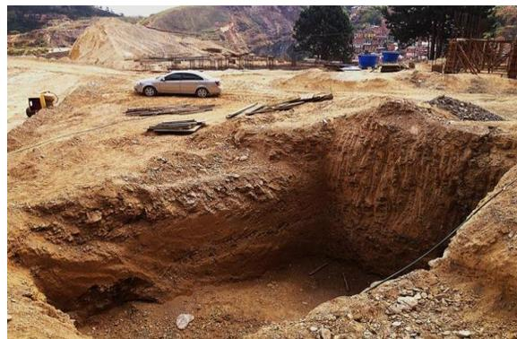
Figura N° 68. Excavación a cielo abierto para tanque en zona cercana a una quebrada intermitente, el grado de meteorización es muy alto y ya se perdió casi en su totalidad la estructura heredada.
