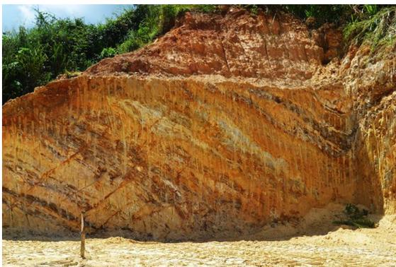
Figura N° 67. Talud con frente de exposición sureste, la estructura heredada intacta en su condición de RmMdf y en sentido favorable a la estabilidad cinemática.
