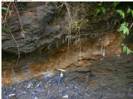
Zona de brecha de falla. Afloramientos meteorizados y plegados.
