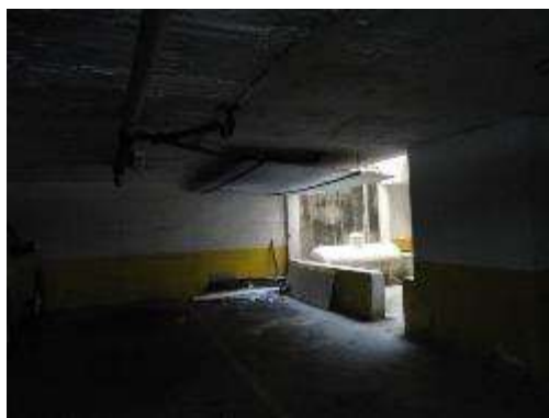
Imagen 46: Humedad losa techo. Caso estudio 2. Fuente FF.
