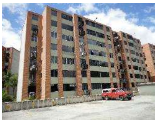
Imagen 100. Fachada oeste. Torre H. Fuente FF
