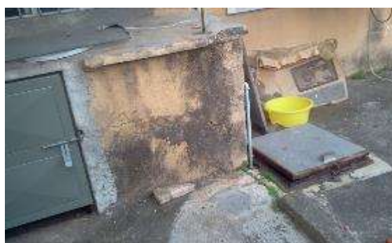
Fotografía 31. Boca de visita de tanque subterráneo y espacio de bombas. Fuente FF
