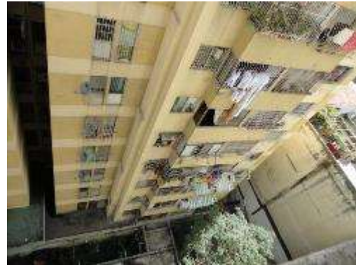
Imagen 33. Fachada sur de la edificación. Estado actual 2. Fuente FF
