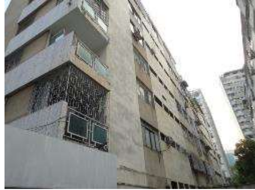
Imagen 13. Fachada norte, colocación de rejas y equipos de A/A. Fuente FF
