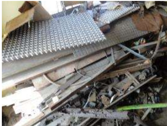
Imagen 96: Escombros de actualización ascensores en cuarto de máquinas. Caso estudio 5. Fuente FF
