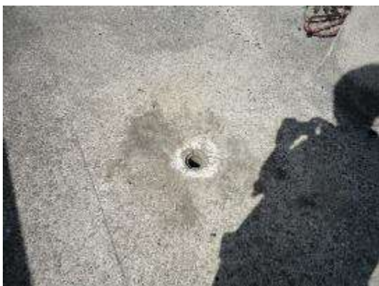
Imagen 77: Detalle techo. Drenaje aguas de lluvia sin protección. Caso estudio 1. Fuente FF
