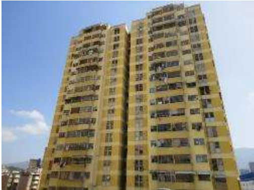
Imagen 32. Fachada sur de la edificación. Estado actual. Fuente FF
