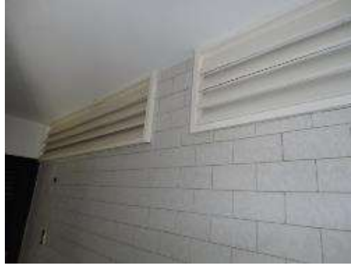
Imagen 90: Detalle planta tipo. Rejilla de ventilación sanitario apartamentos hacia áreas las comunes. Caso Estudio 4. Fuente FF
