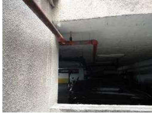
Imagen 15. Instalación de sistema de extinción de incendios. Fuente FF
