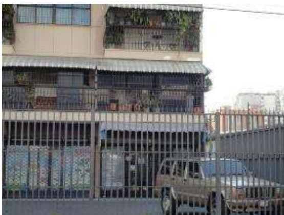
Imagen 63: Fachada principal. Techo ligero sin mantenimiento. Caso estudio 1. Fuente FF
