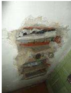
Imagen 40. Trabajos de reparación Acometida aguas claras. Fuente FF
