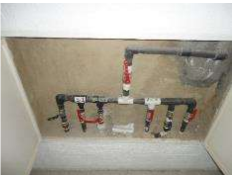
Imagen 113. Planta tipo caja llaves de paso aguas claras. Torre H. Fuente FF
