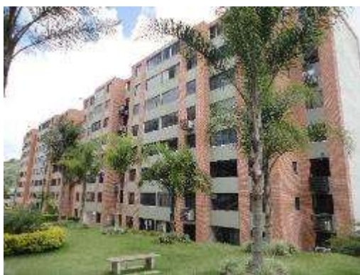
Imagen 99. Fachada este. Torre H. Fuente FF
