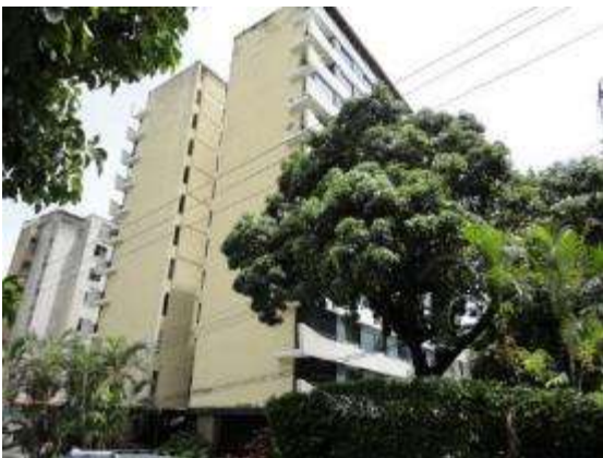
Imagen 55: Fachada principal. Pintura desconchada. Caso Estudio 3. Fuente FF
