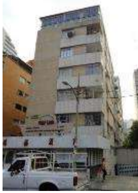
Imagen 12. Fachada principal, estado actual. Fuente FF
