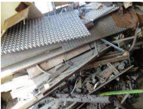
Imagen 34. Escombros dejados por empresas que actualizaron los ascensores. Fuente FF
