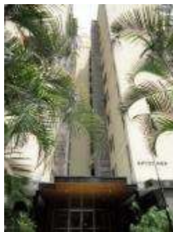
Imagen 22. Fachada este, acceso edificación
