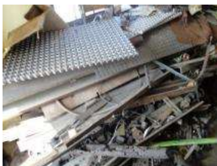
Imagen 84: Escombros acumulados en sala de máquinas. Caso estudio 5. Fuente FF
