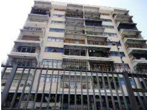
Imagen 2. Fachada principal deteriorada. Fuente FF
