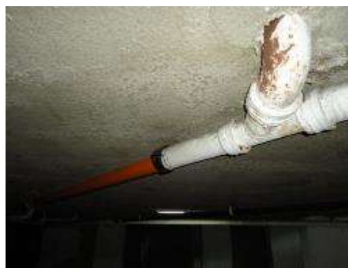
Imagen 11. Cambio material de tubería de aguas negras en sótano. Fuente FF
