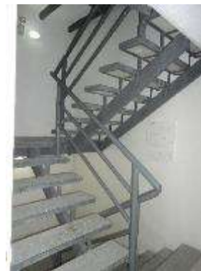
Imagen 106. Escaleras de emergencia. Torre H. Fuente FF
