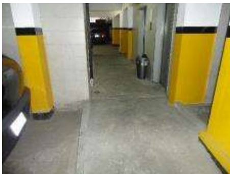
Imagen 20. Construcción de pavimento para impedir inundación del pozo de los ascensores
