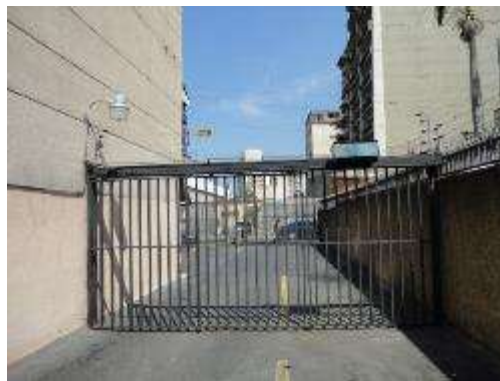
Imagen 9. Portón eléctrico y otros mecanismos de seguridad en acceso vehicular en PB. Fuente FF
