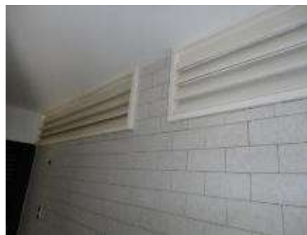
Imagen 23. Rejillas ventilación sanitarios hacia áreas comunes
