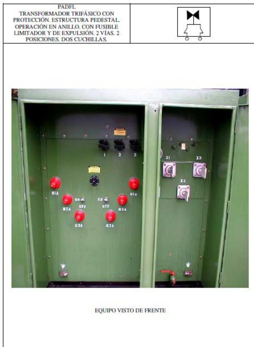
Figura A3.2. Transformador tipo pedestal
