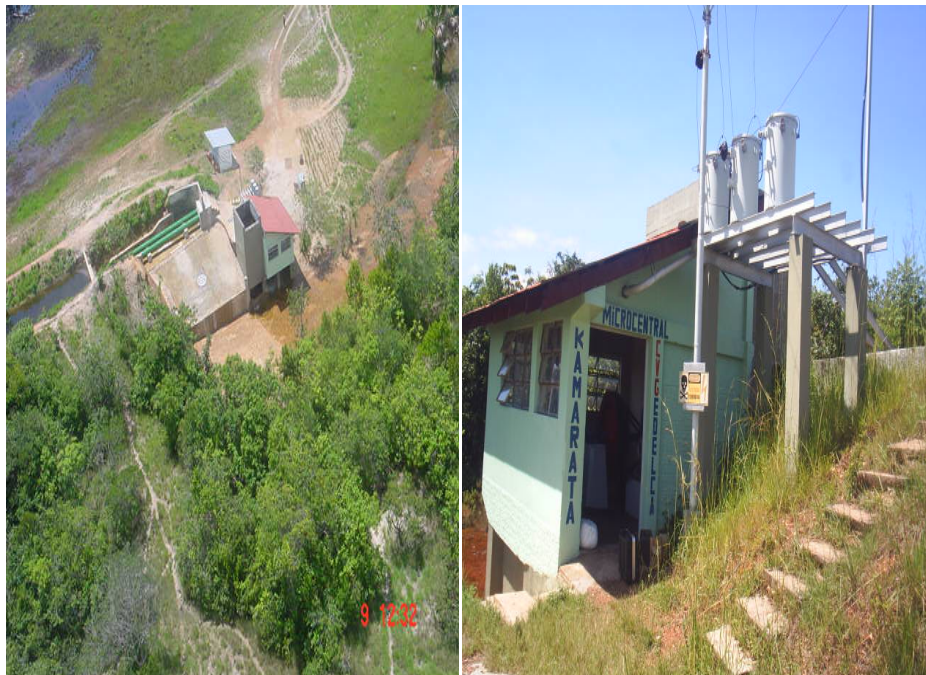
Foto 20: Central Hidroeléctrica EDELCA de 60kVA de Comunidad Kamarata [35]
