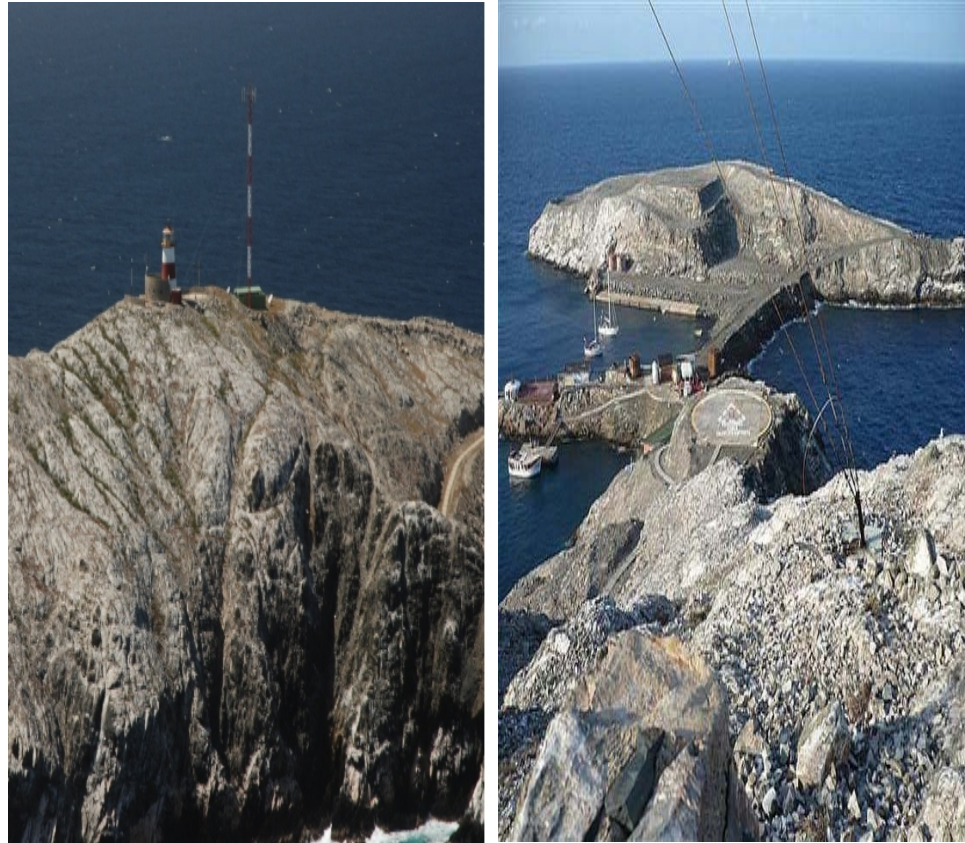
Foto 6: Isla los Monjes, Estación Radio Base Actual CDMA Satelital [35]
